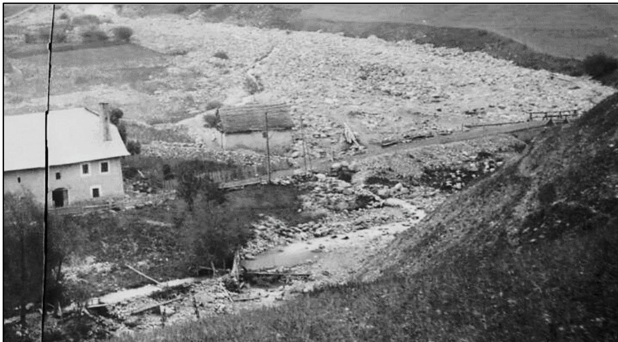
En bas, sous les constructions, deux ouvrages : la prise d'eau du canal et semble-t-il une martelière.
