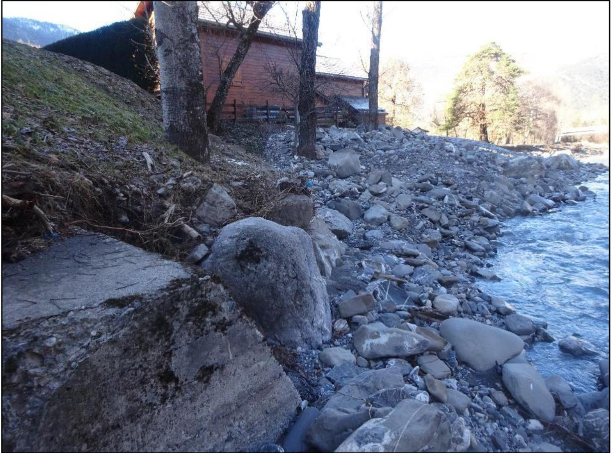
Au premier plan, la pointe d'un épi en béton datant des années 1960, plus loin protection de constructions par rechargement de la berge avec des pierres et du gravier.
