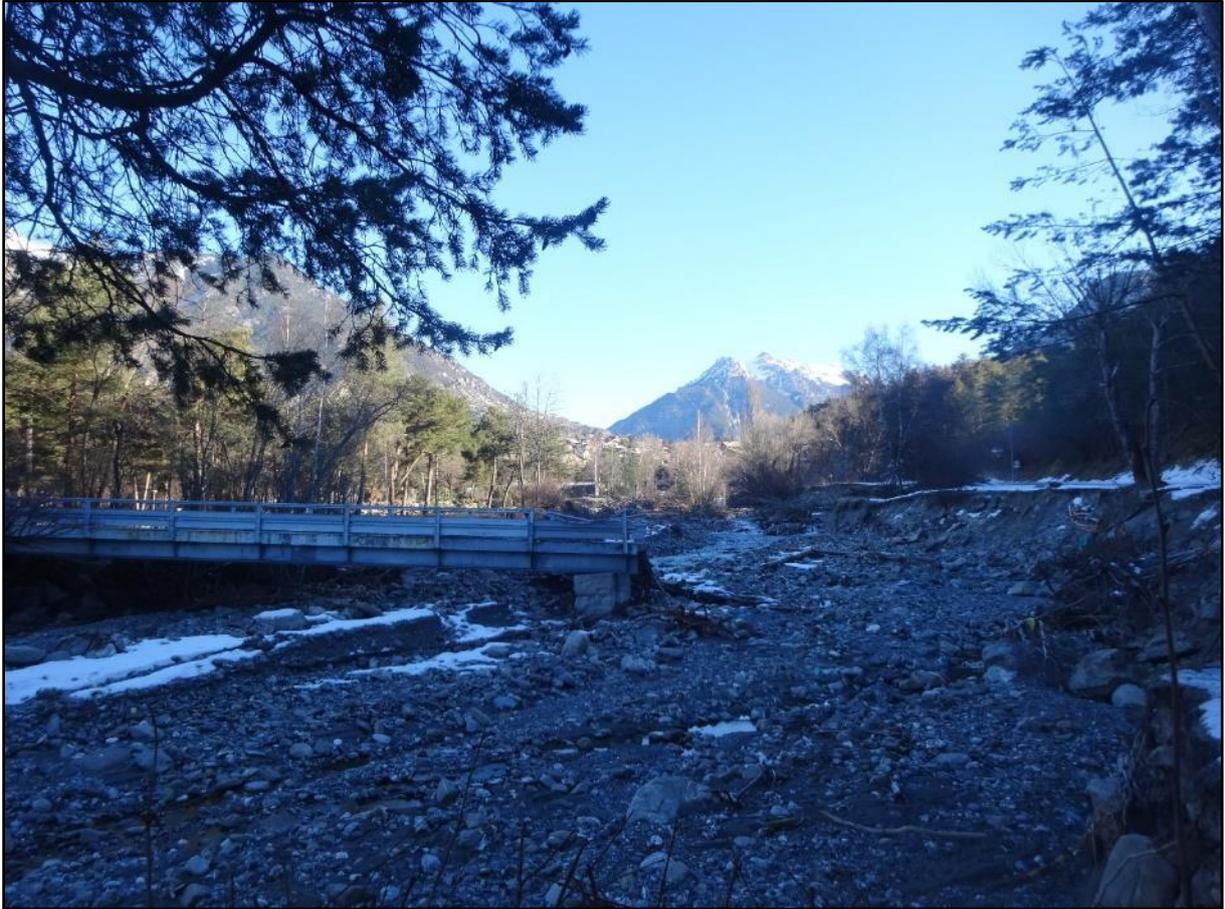
A-t-il été un obstacle pour le courant ? En tous cas la furie des eaux l'a contourné, creusant et coupant tout lien entre le tablier métallique du pont et la route. La partie droite du lit du torrent était auparavant au niveau de la route.
