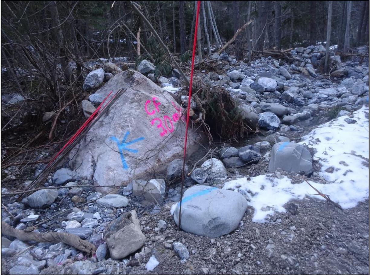
Tiges métalliques pour jalonner, écrits sur le rocher et en bleu je pense données pour une canalisation hydraulique souterraine.
