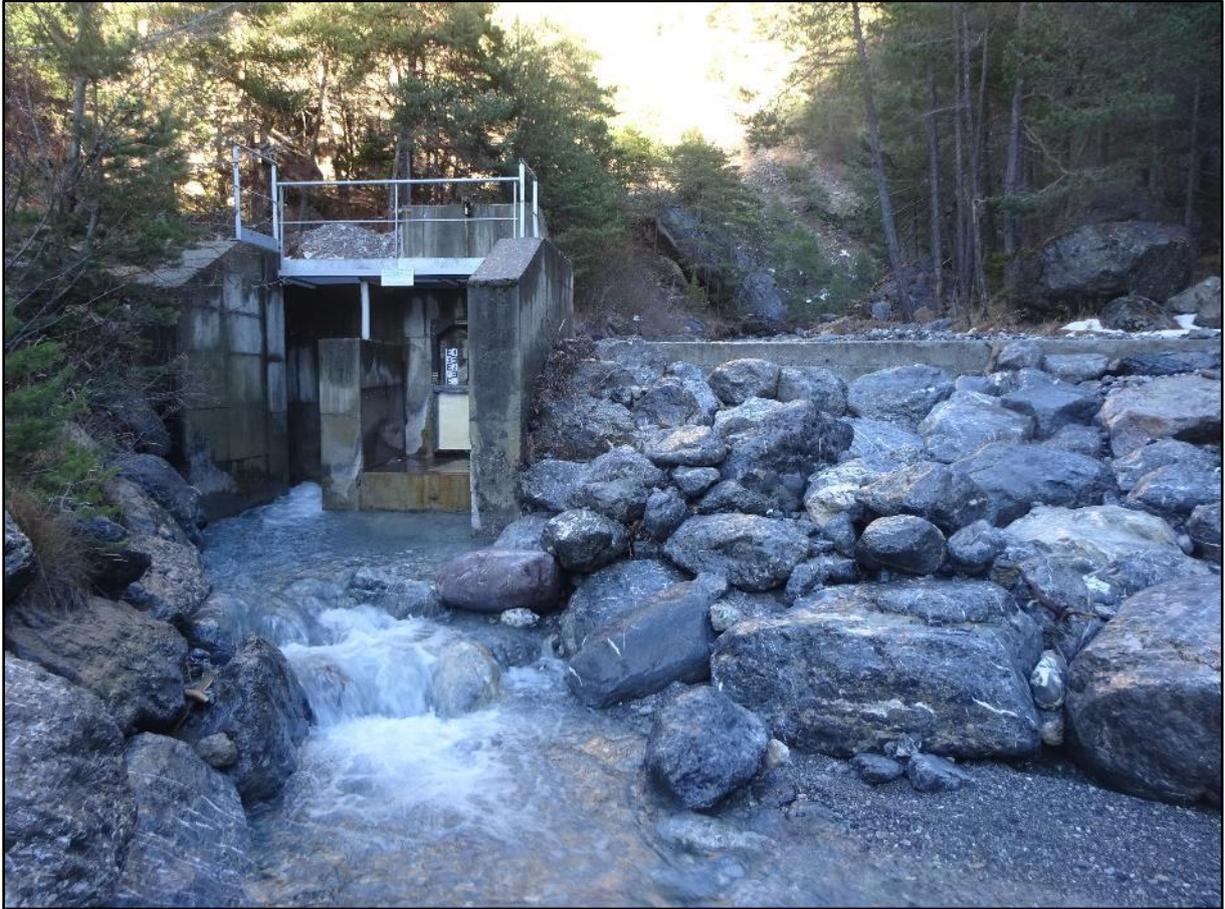
La prise d'eau à gauche, le barrage en béton à droite créant une petite retenue et un enrochement de protection.
