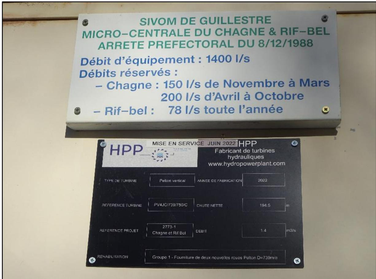
Pour ceux qui aiment les chiffres. La turbine est neuve, la hauteur de chute de près de 200 m, le débit dépasse bien 1 m<sup>3</sup> / seconde.
