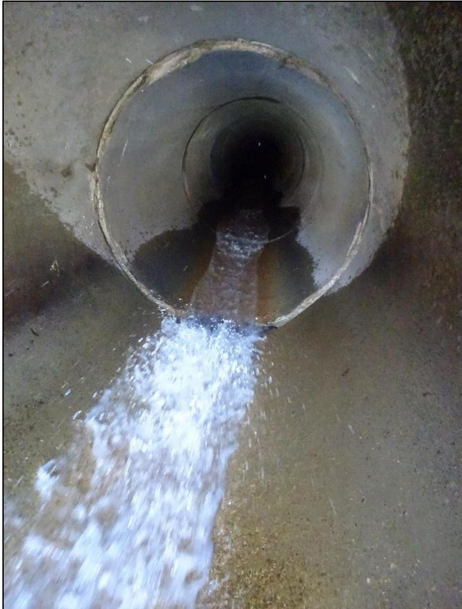
Le flux est rapide, on pourrait entrer à quatre pattes dans la conduite, mais ce n'est pas nécessaire. Géoportail montre qu'elle fait pratiquement 600 m de longueur avec un dénivelé de 70 m environ, soit une pente moyenne supérieure à 10%.
