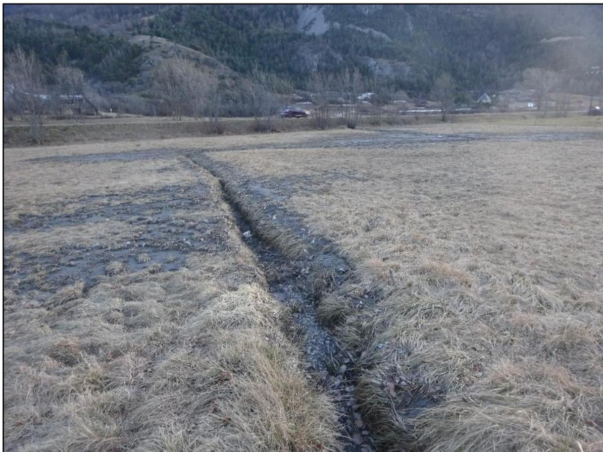
Une canalisation passe sous la levée de la nationale et la boue se répand par la prise d'arrosage, se déversant tantôt d'un côté tantôt de l'autre.
