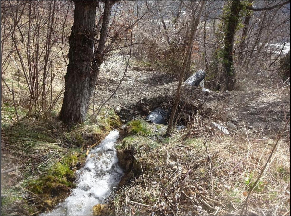
Là, le torrent a pris la tangente sur la gauche et a raviné un bout de chemin d'exploitation. Le placement d'une buse en a rétabli le cours.
