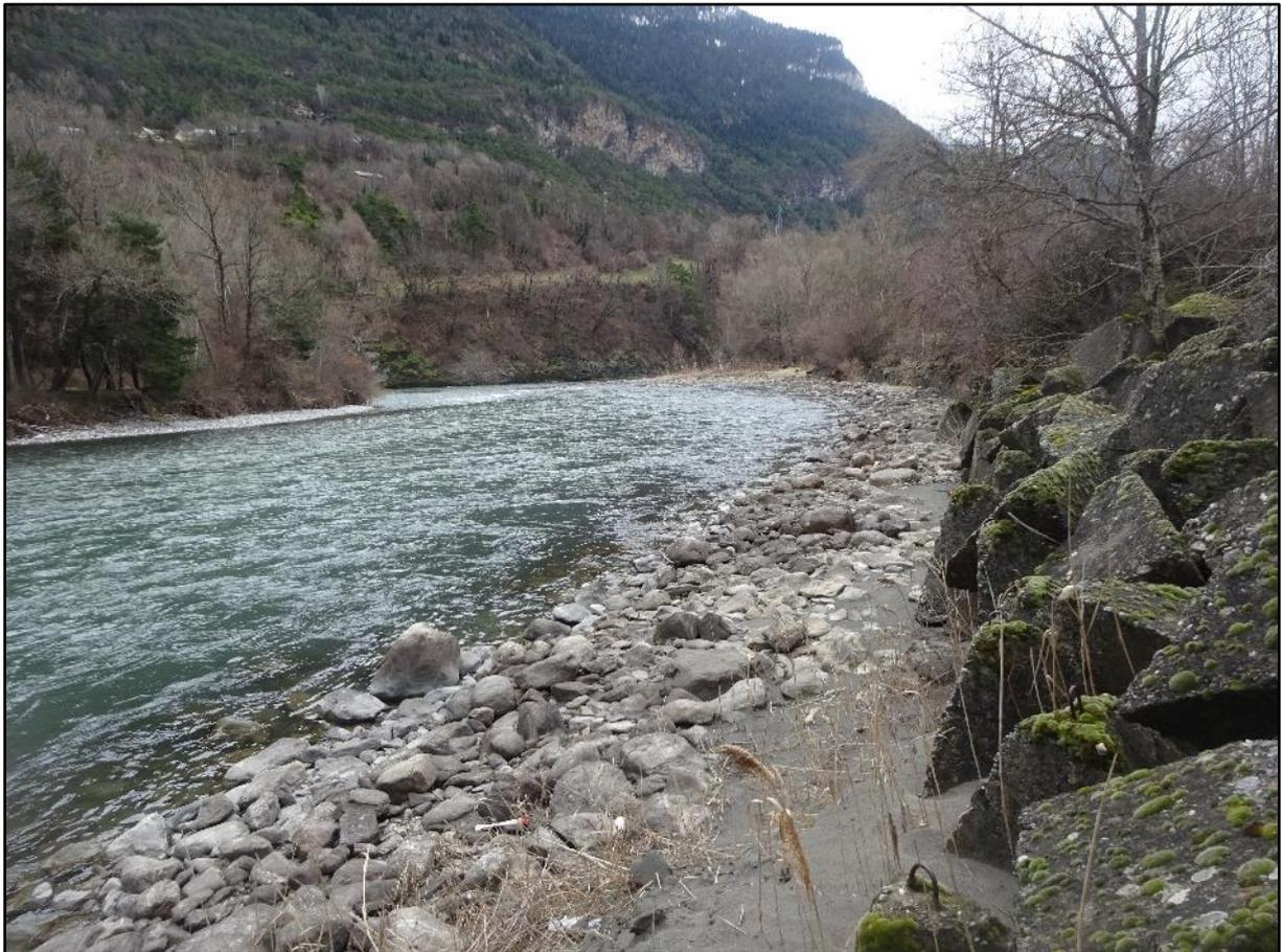
Tout au long de ce même virage, on retrouve la protection de la rive et des terrains par des blocs au cône triangulaire. J'ai compté qu'il y en a environ 20 par mètre linéaire.
