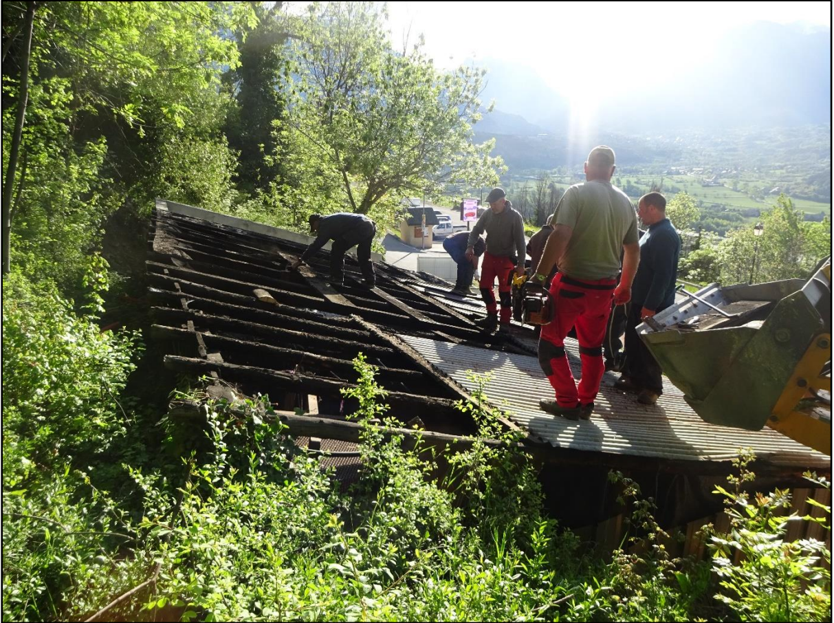
Image n°5 : au cours du démontage des tôles
