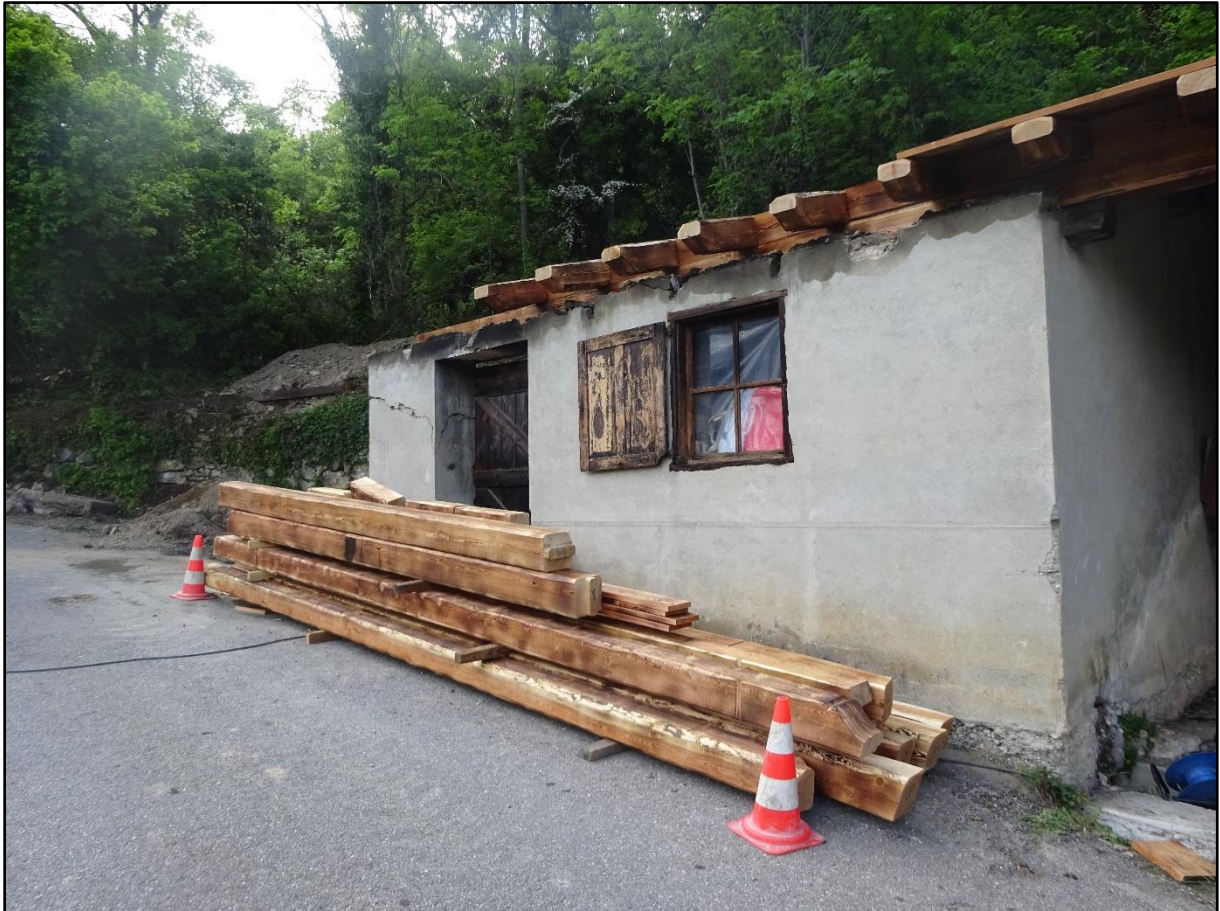
Image 32 : la façade à J + 2
