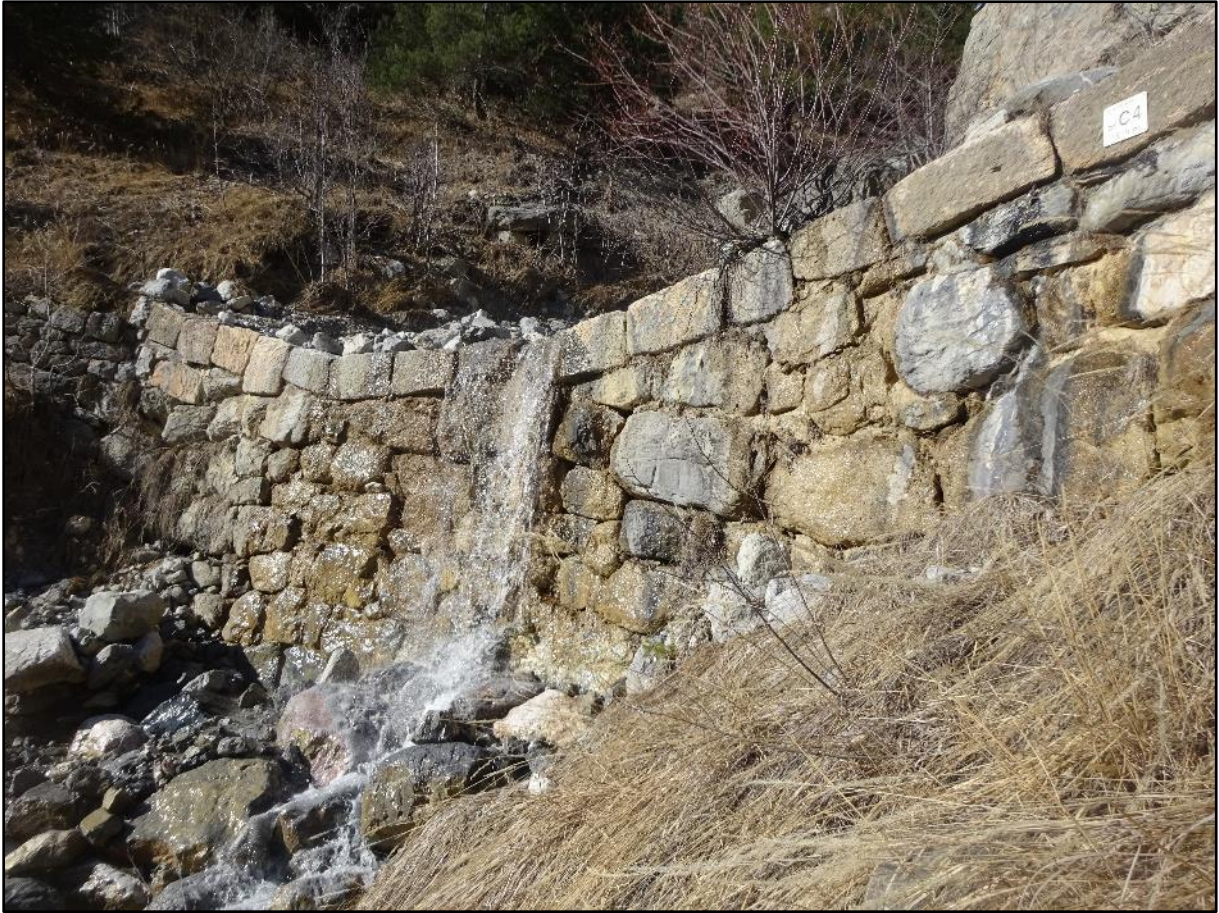
Image 20 : seuil couvert de pierres de taille
