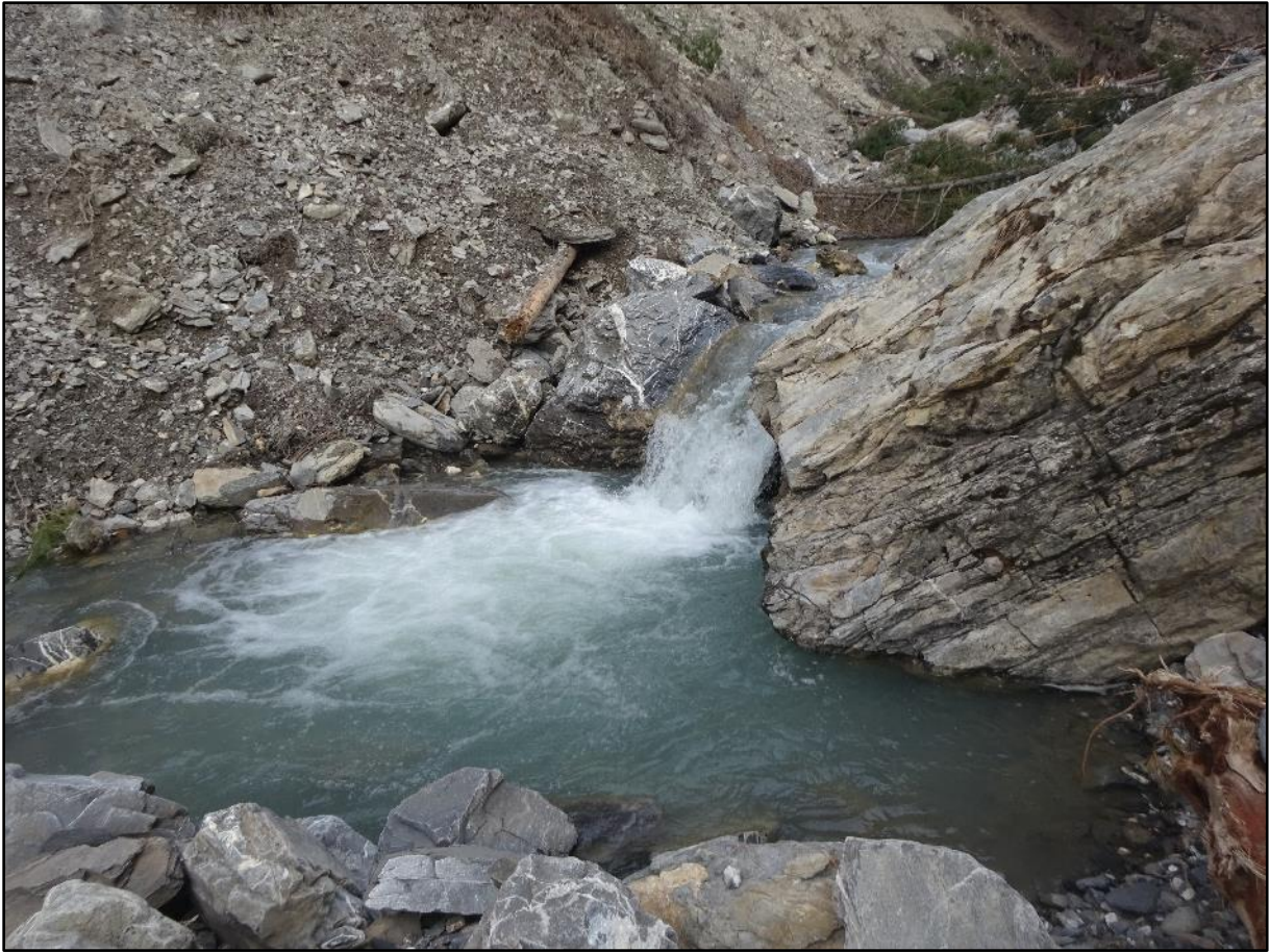
Effet d'eau au niveau du glissement de terrain.
