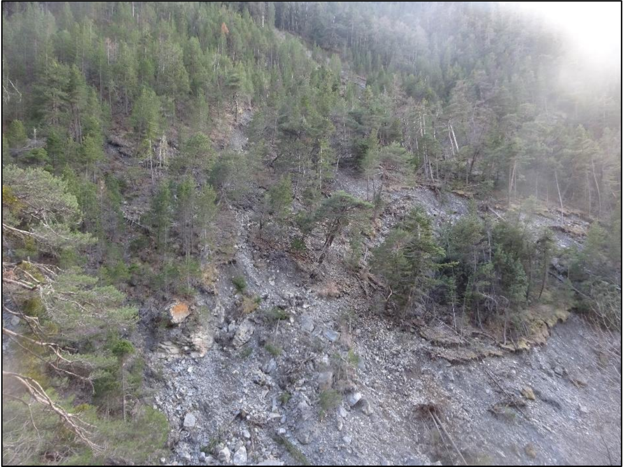
Image 25 : sous le pont retrouvé
