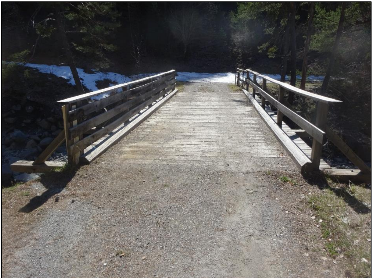
Image 1 : le pont de Panacelle
