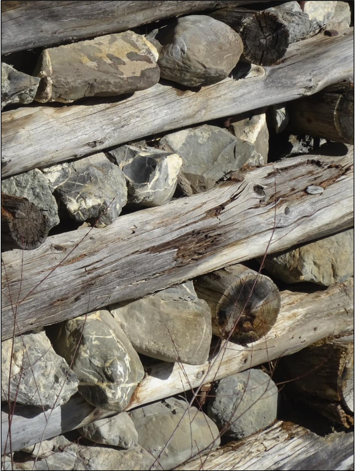
Entrecroisement perpendiculaire de poutres, rempli de pierres.
