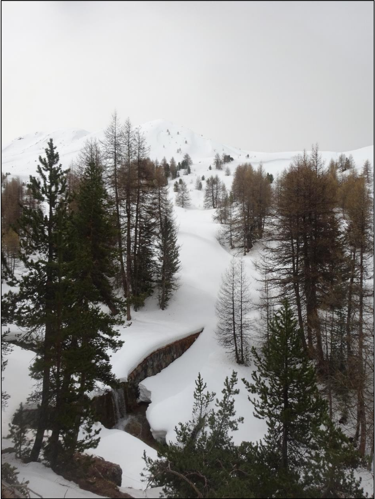
Image 10 : en amont du seuil
