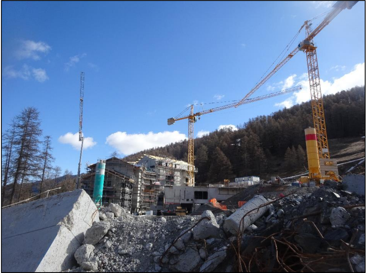
Image 26 : autre vue du chantier
