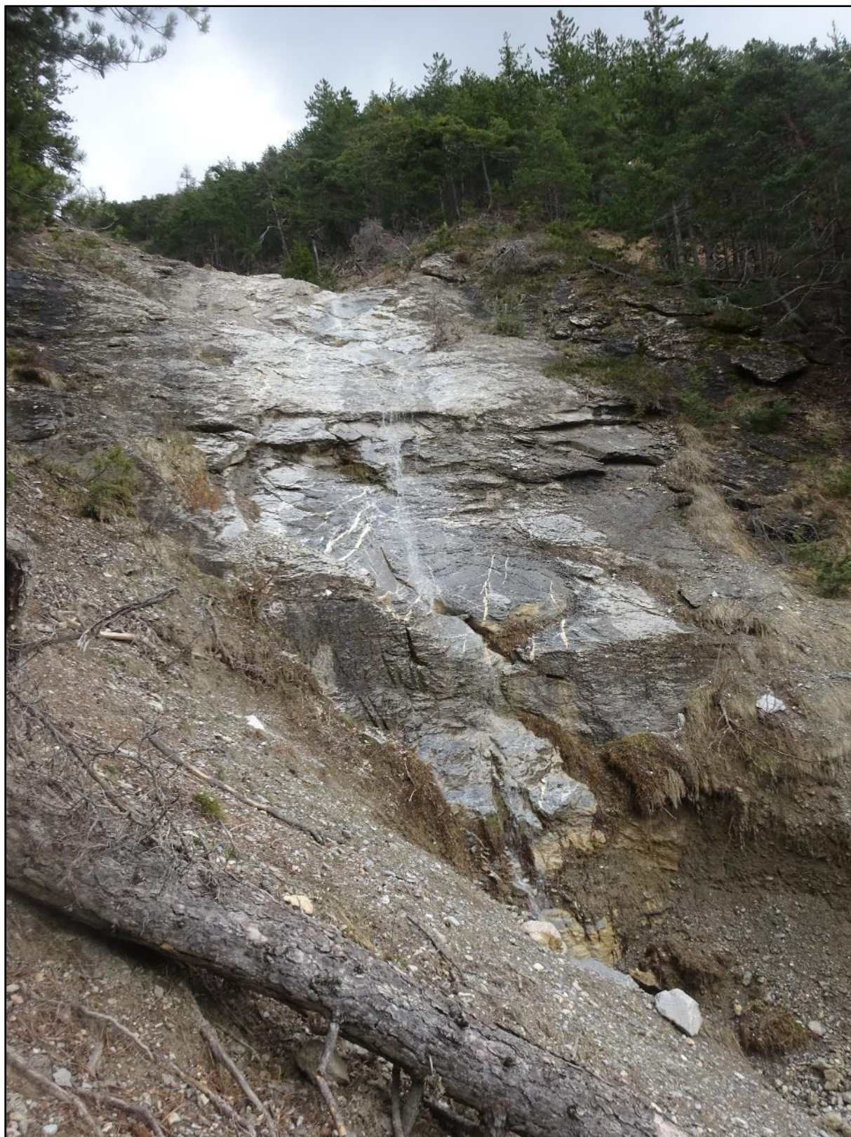
Une cassure rocheuse bien nettoyée par la crue.
