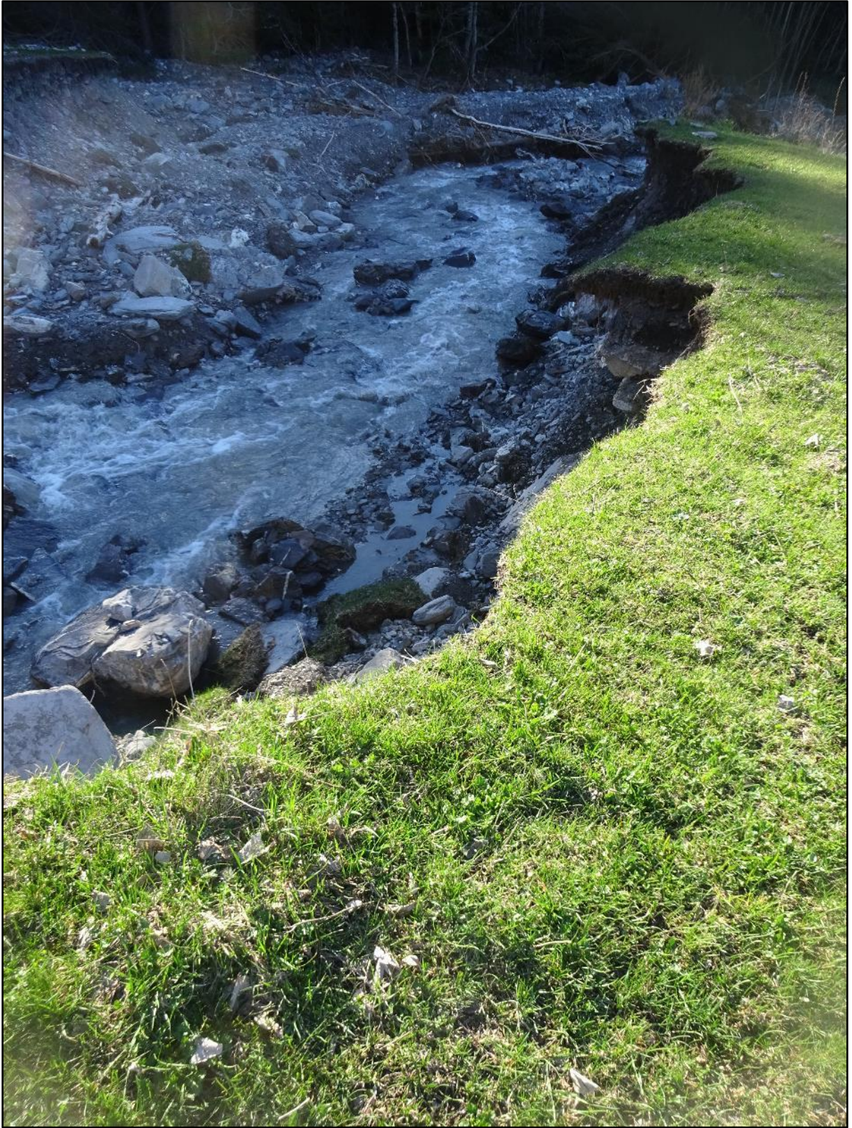
Image 3 : vue sous la chapelle
