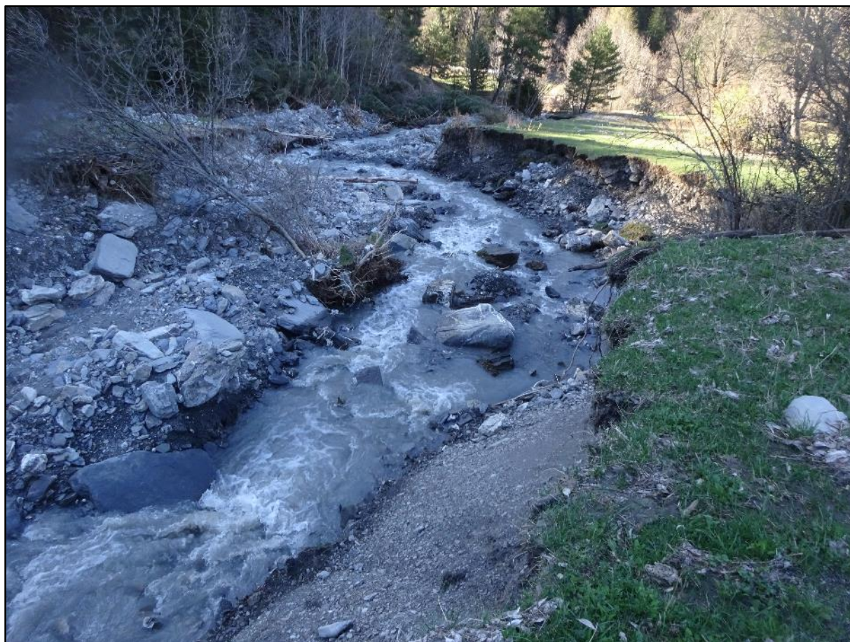
Image 2 : vue sous la chapelle
