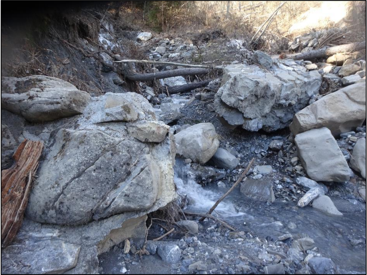
A 1400 m d'altitude. Deux restes maçonnés de l'ancien pont.
