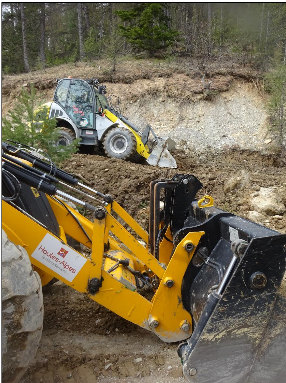
Image 22 : retour au chantier
