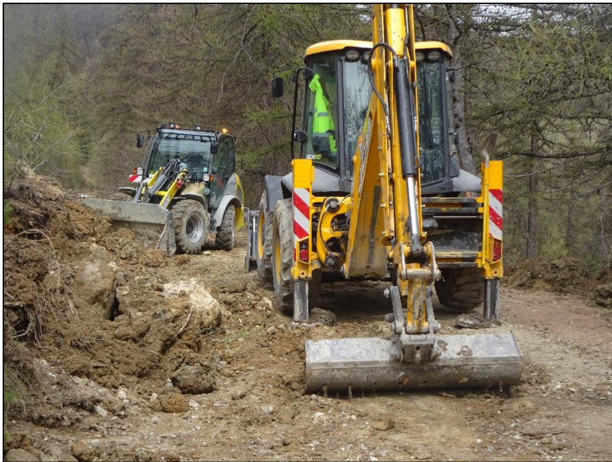
Image 23 : retour au chantier
