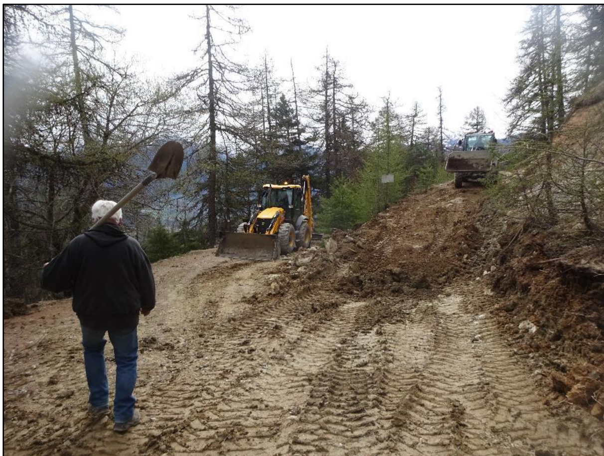
Image 21 : retour au chantier
