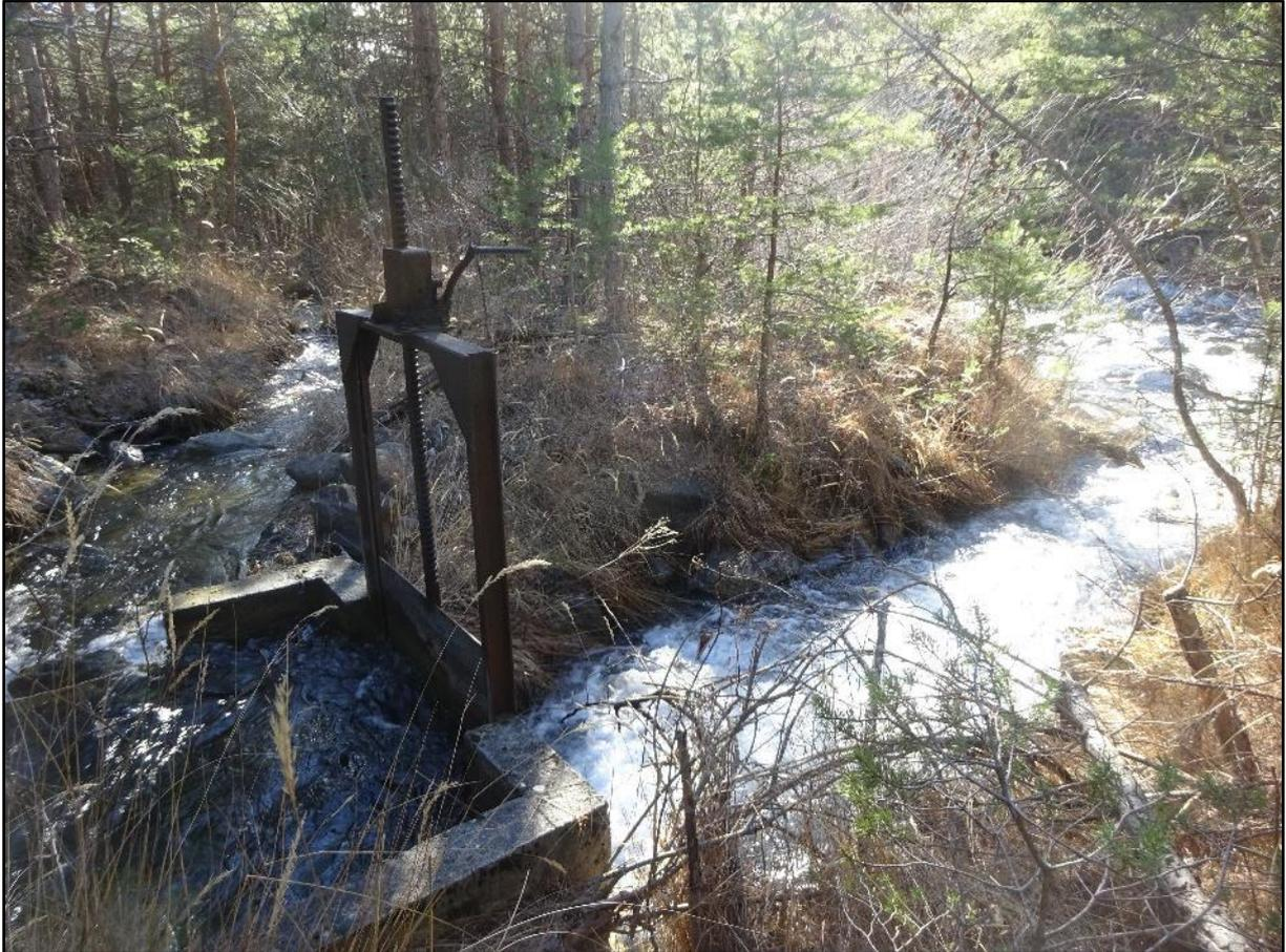
Quelques mètres après la sortie de l'eau de la microcentrale, le flux est partagé en deux. A droite il rejoint directement le torrent, à gauche il s'avance dans le bois en direction de la vanne de la digue, allant soit au canal des Moulins soit retournant au torrent.
