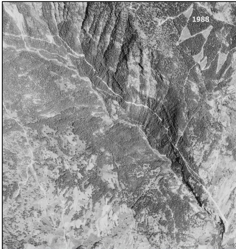
Image 26 : le tracé de la conduite (1988)
