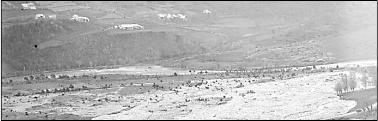
Image 5 : zoom en aval du pont routier
