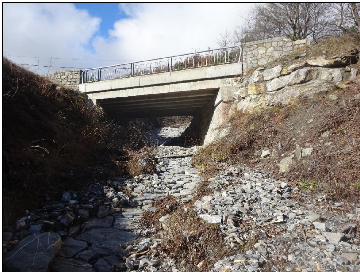
Le pont vu par-dessous avec ses différentes parties.
