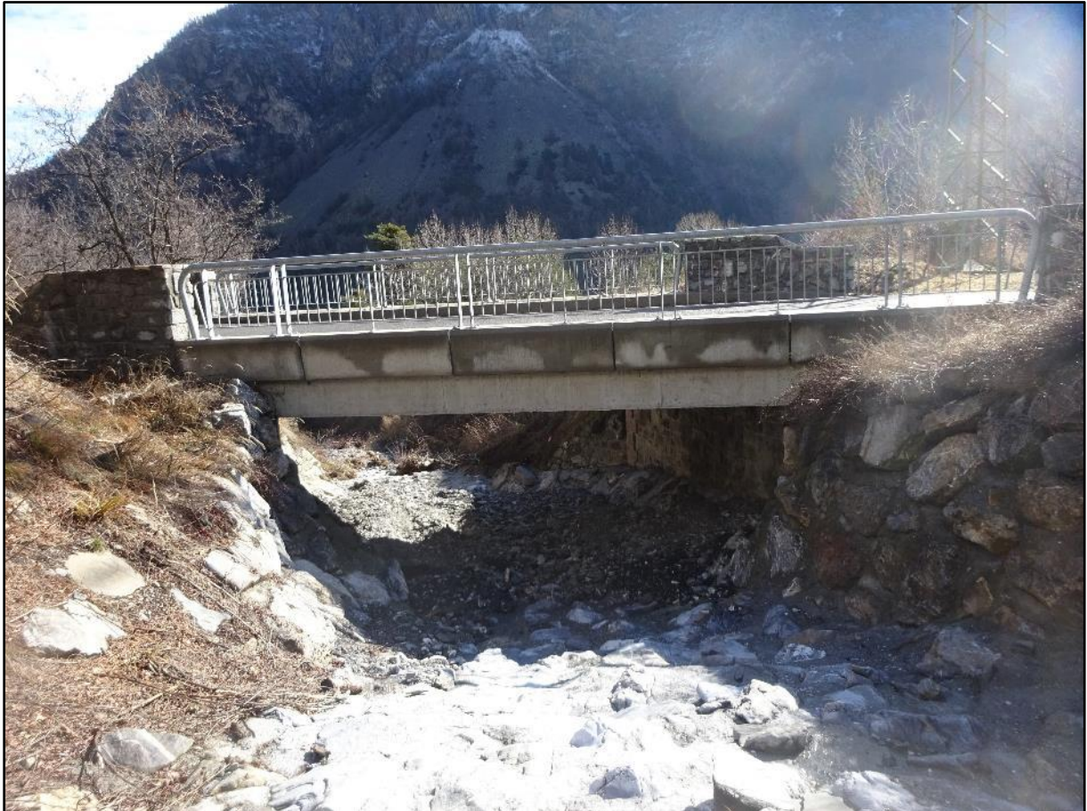
Image 12 : le pont vu d'en haut
