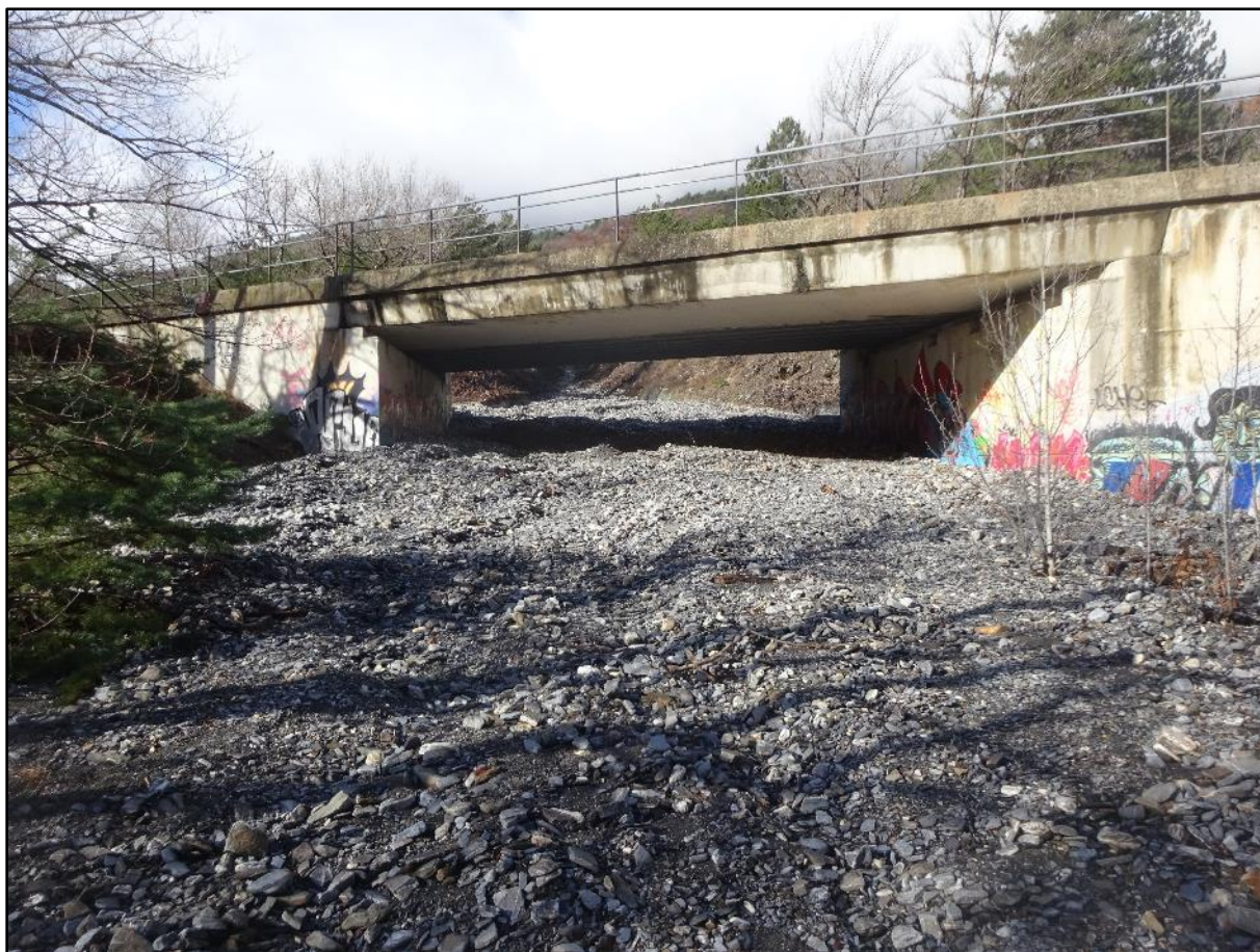
Image 4 : le pont SNCF
