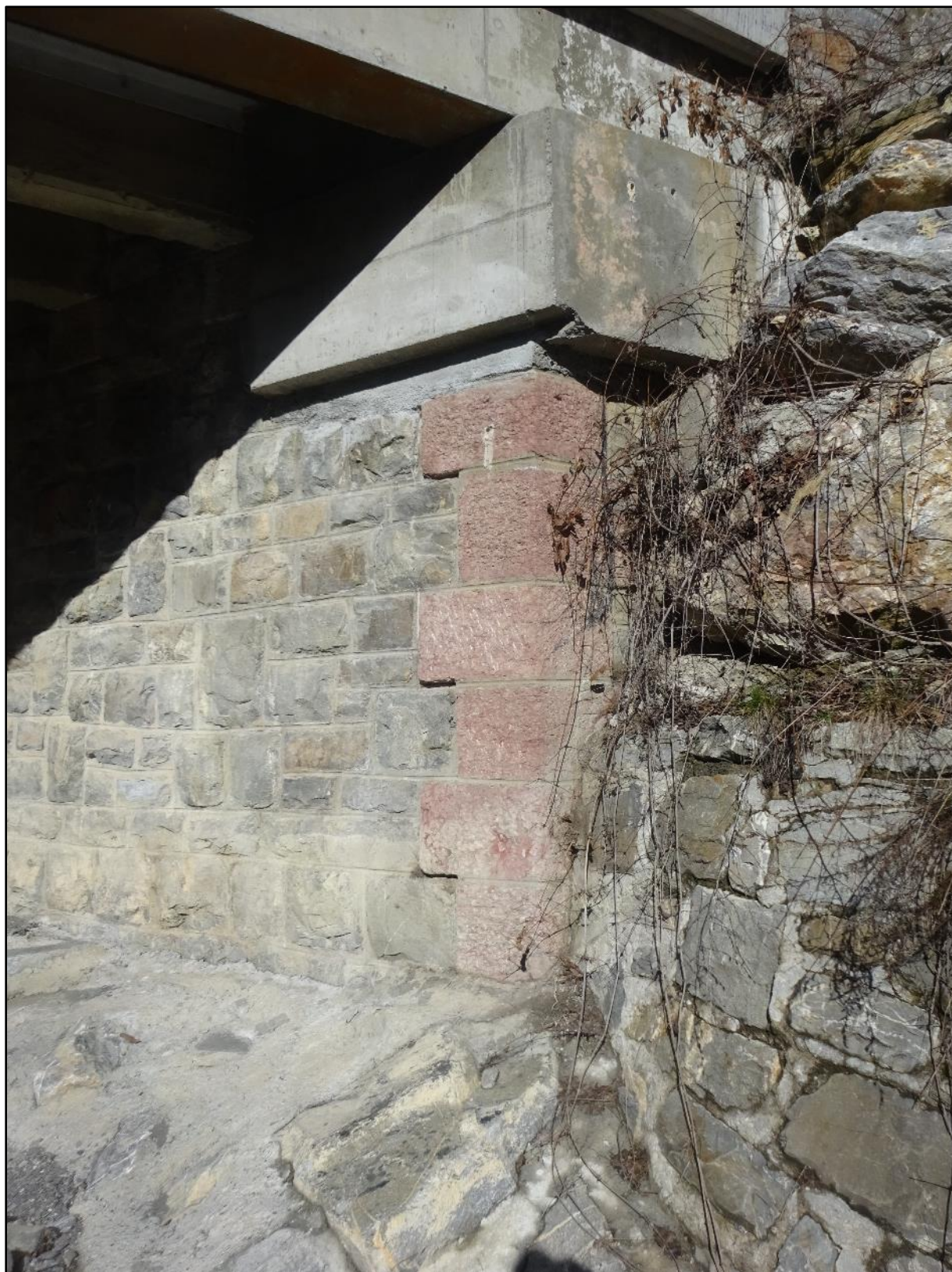
Image 11 : un ouvrage refait
