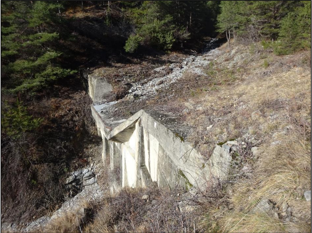
Image 26 : le bunker, vue de profil
