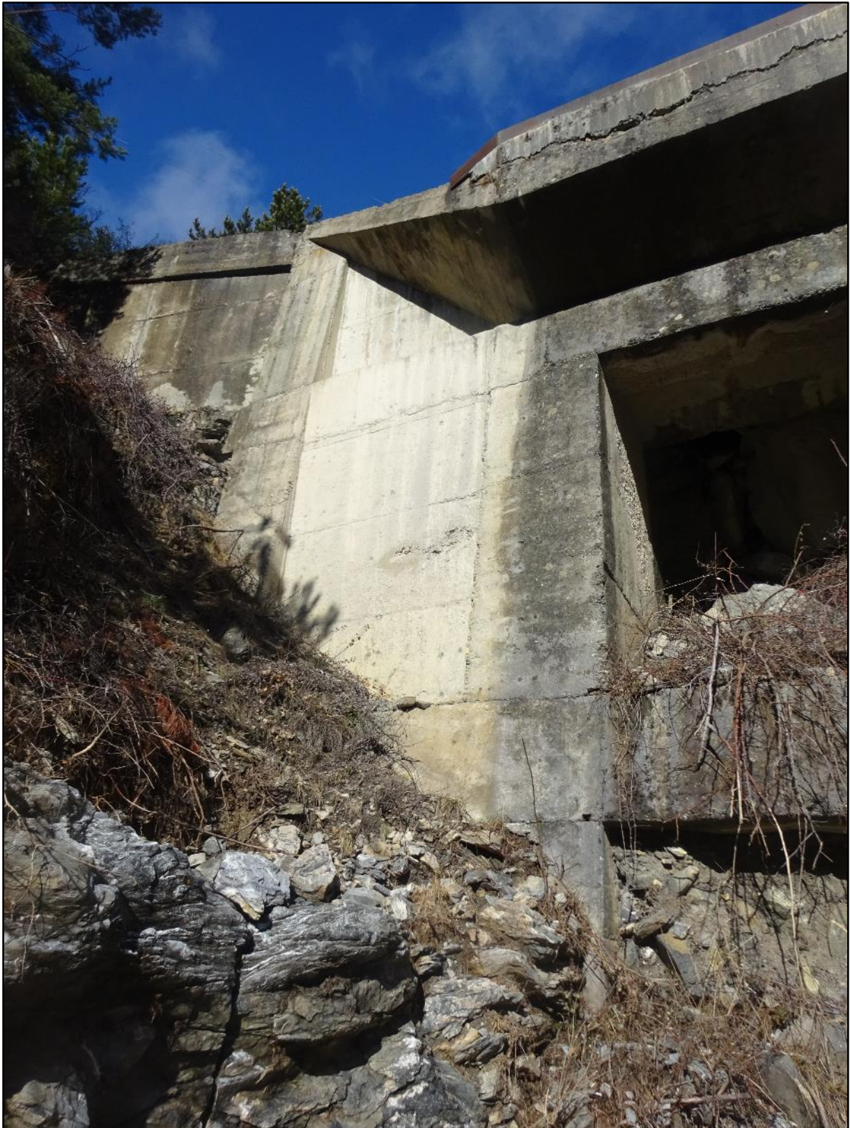
Image 21 : le bunker, partie en rive droite
