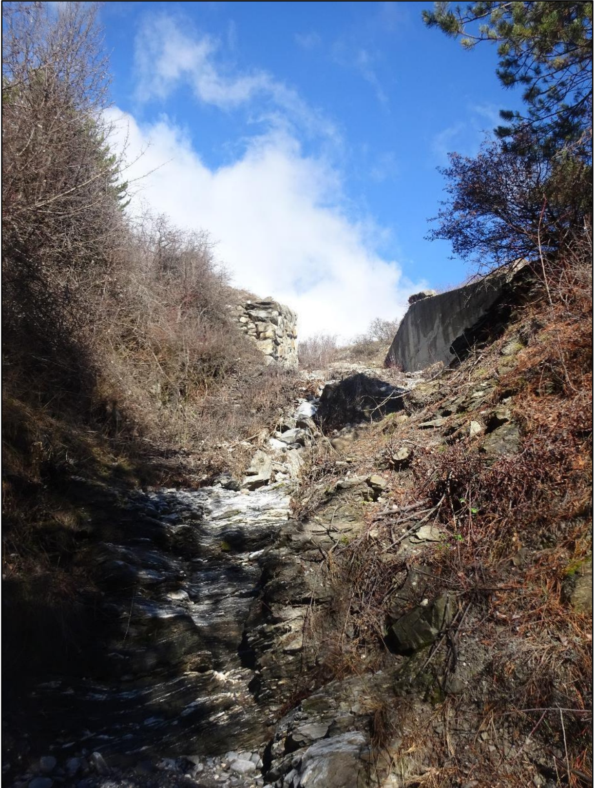
Image 2 : arrivée à un autre ouvrage
