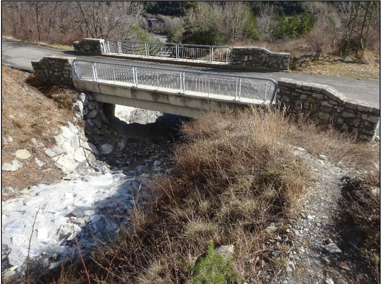
Le pont routier et ses murs latéraux.
