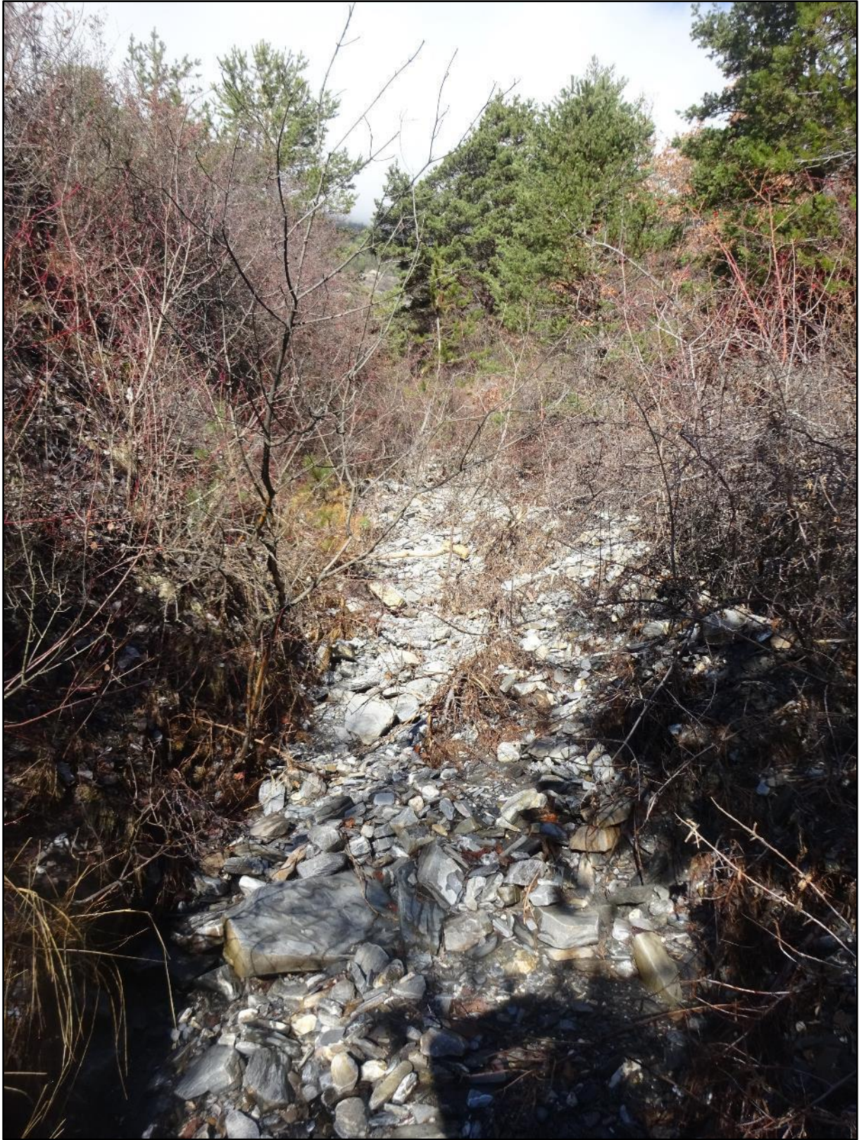
Image 8 : le torrent en amont du 2 ème ouvrage
