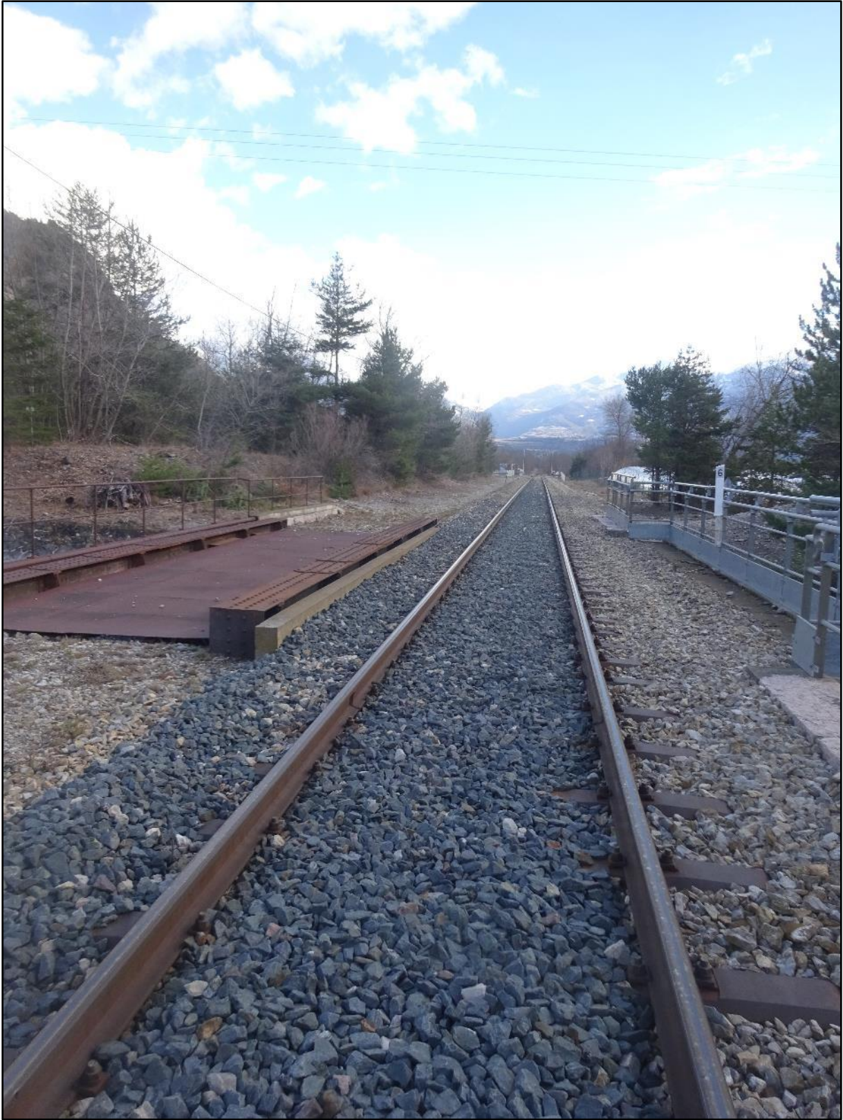
Image 8 : le pont ferroviaire
