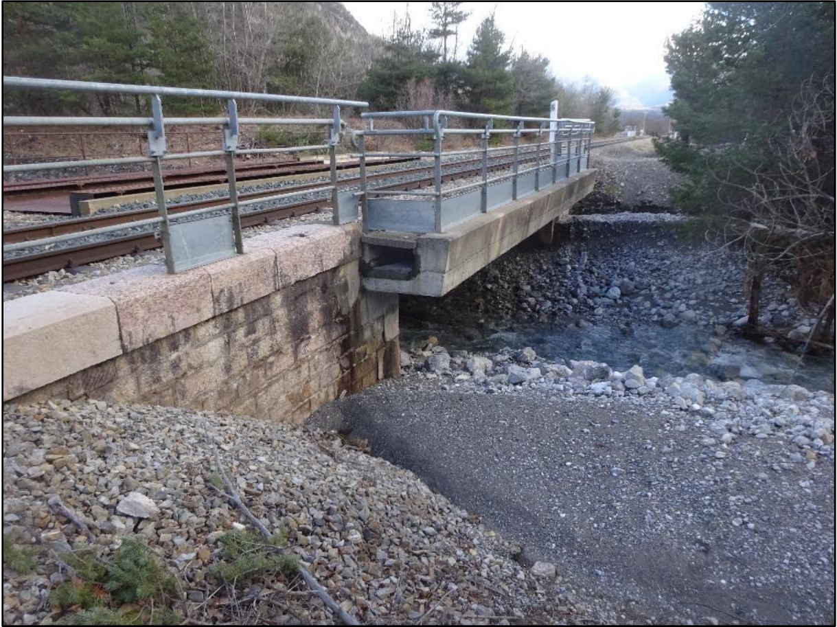
Image 7 : le pont ferroviaire
