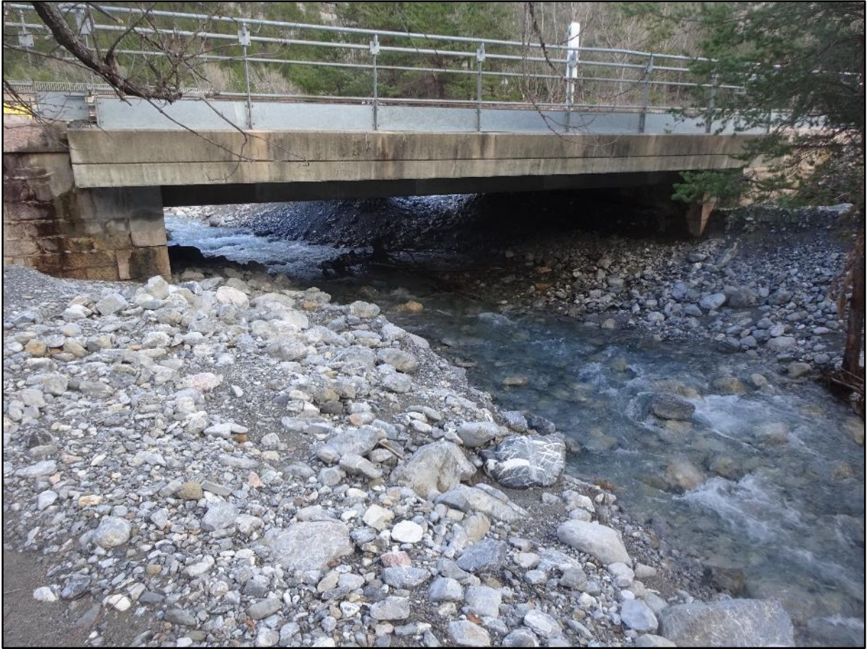
Image 6 : le pont ferroviaire
