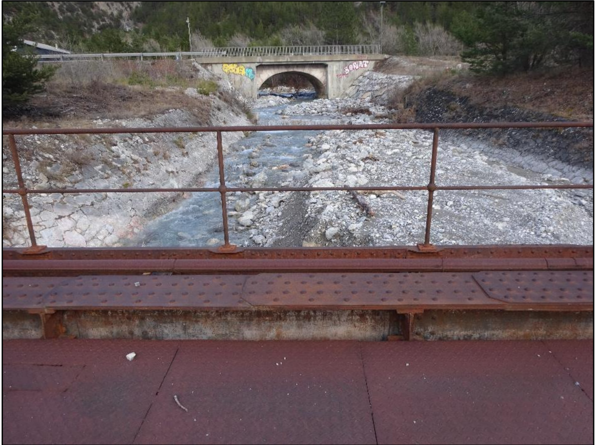
Image 9 : le pont ferroviaire
