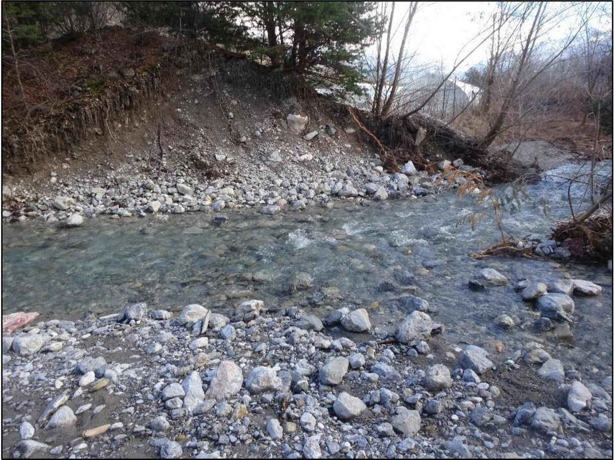
Image 4 : le torrent et des serres
