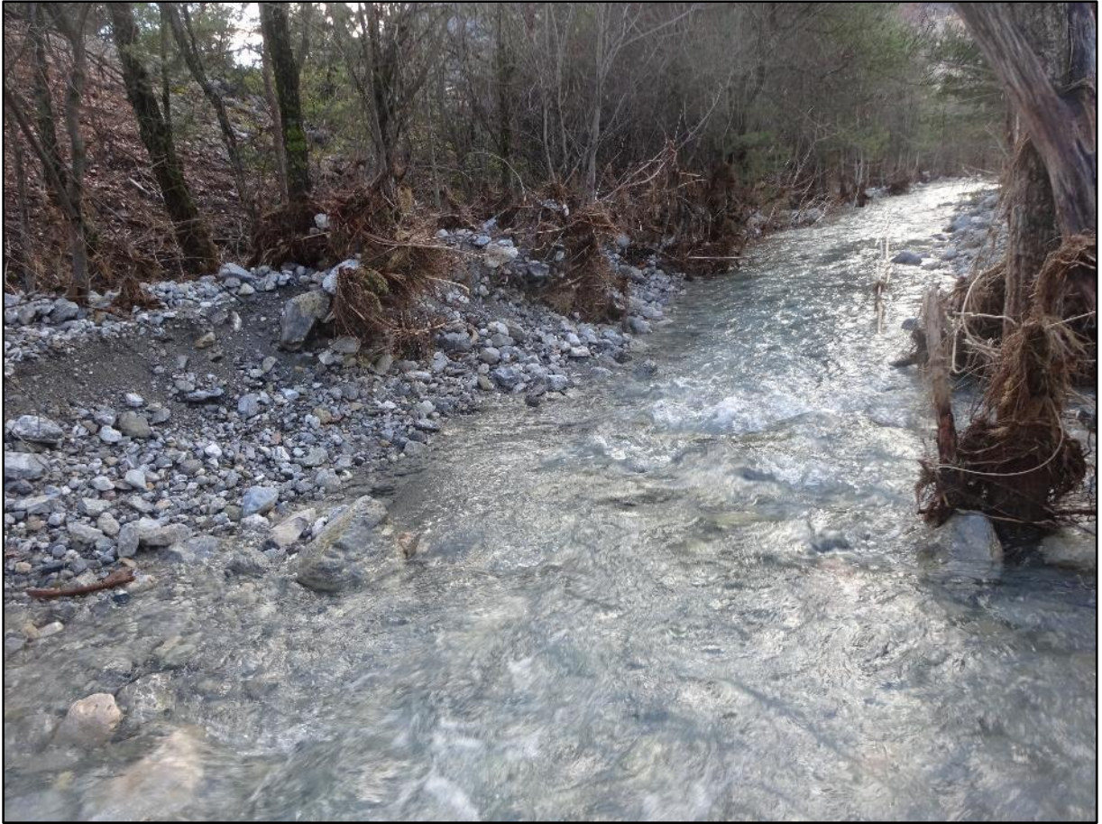
Vue vers l'aval. Le torrent sous le pont ferroviaire.
