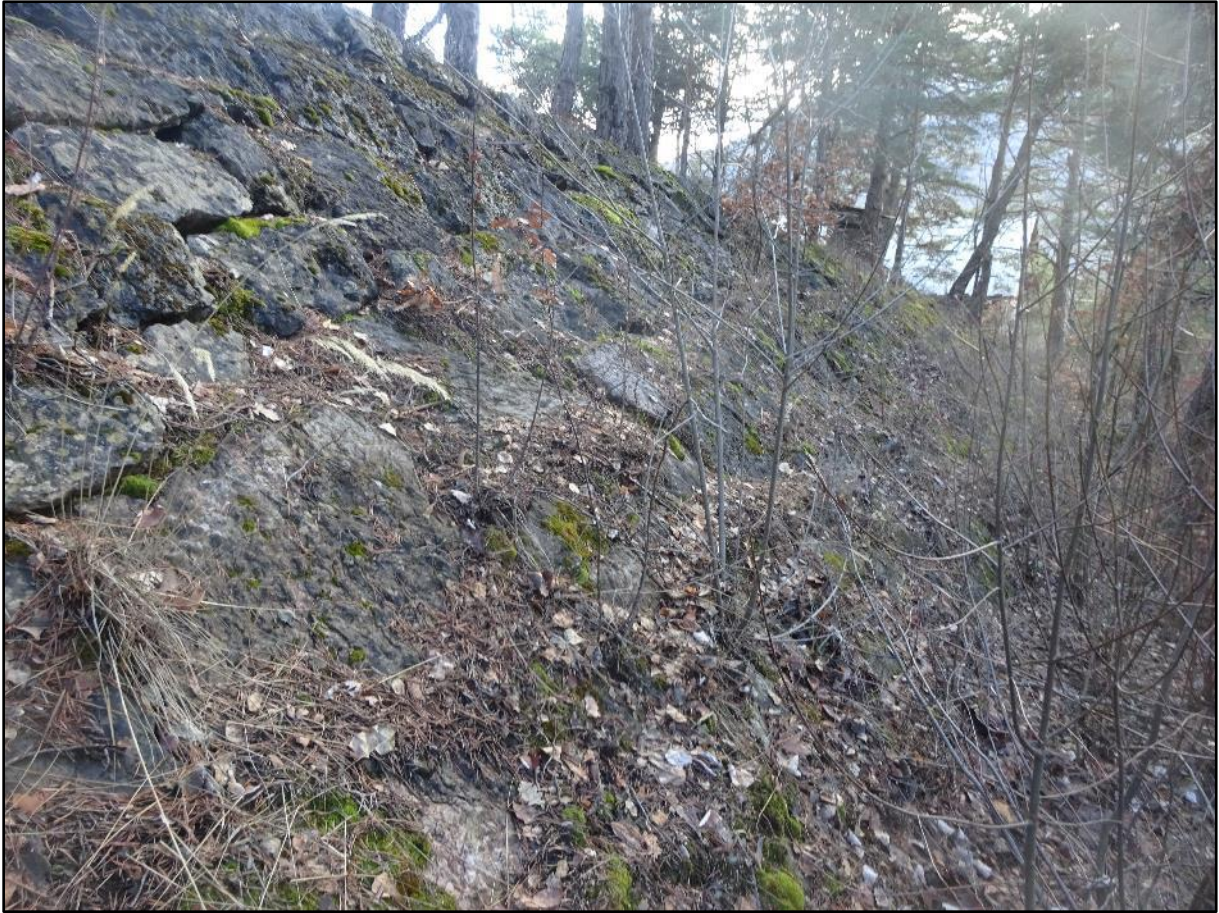
Image 2 : la digue en rive gauche
