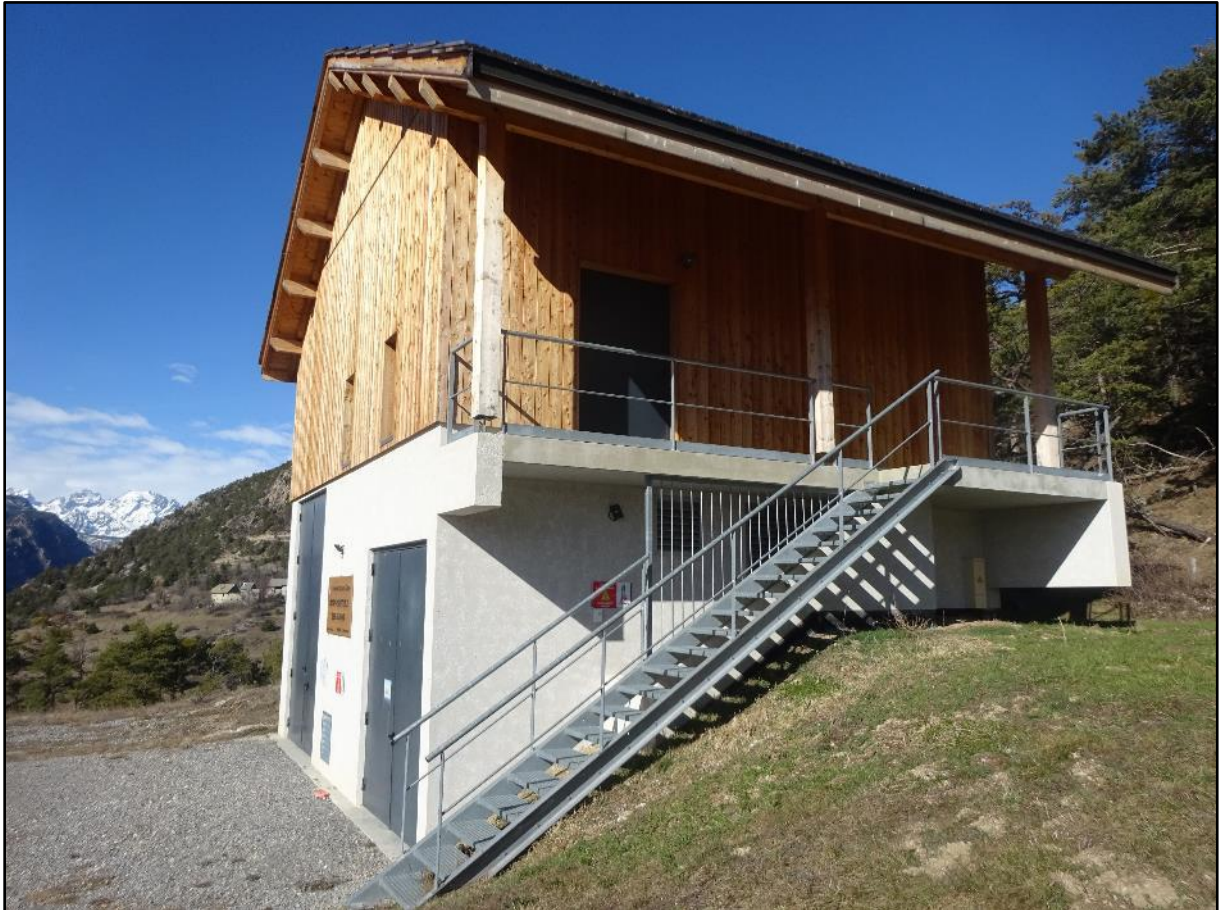
Image 2 : vue latérale de la microcentrale
