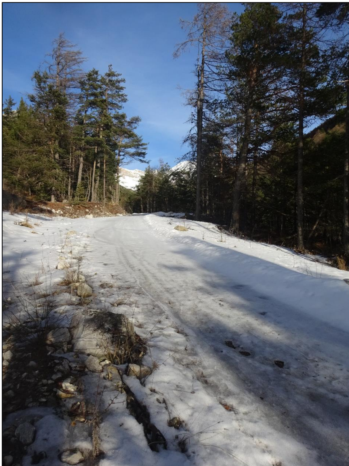
Image 23 : la piste de la conduite forcée
