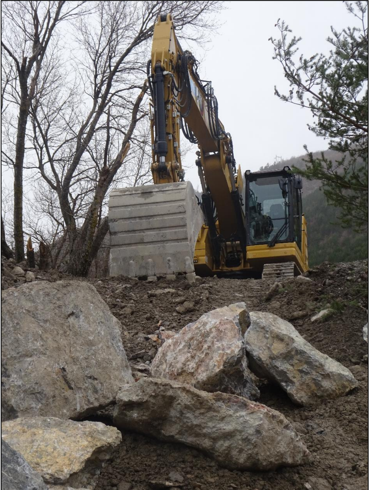
Image 14 : une pelle mécanique
