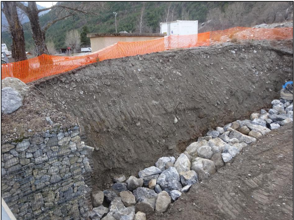
Image 24 : vue de la rive droite en amont du pont
