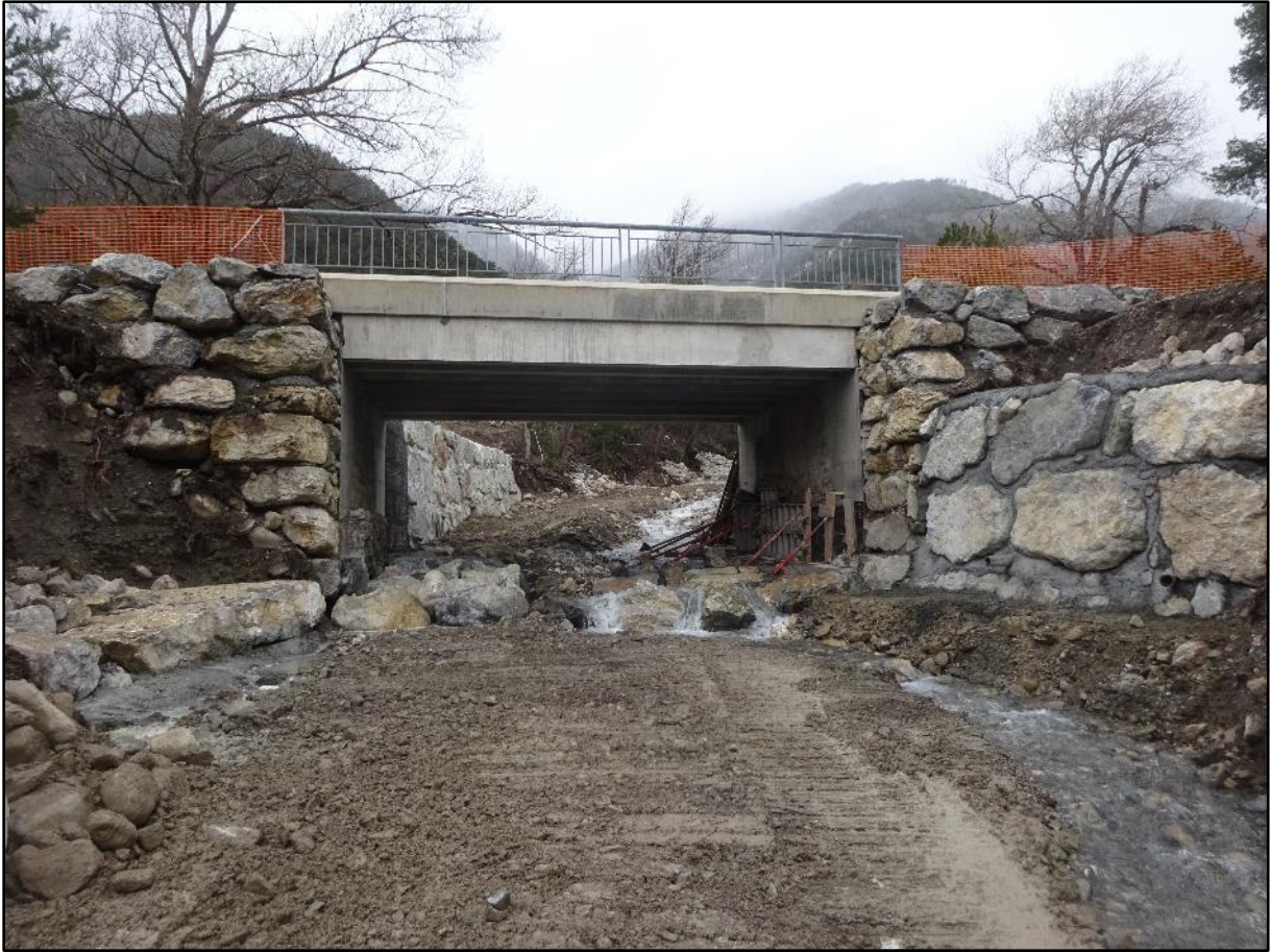
Image 15 : les travaux sous le pont
