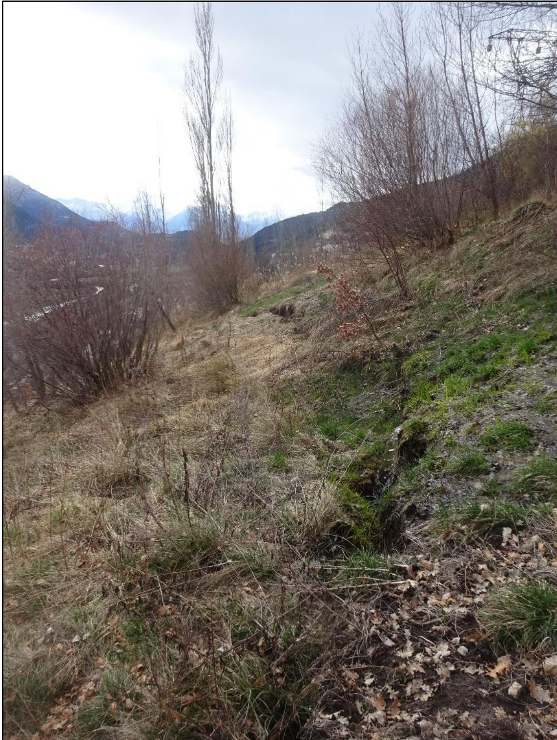
Image 5 : une fissure dans la pente
