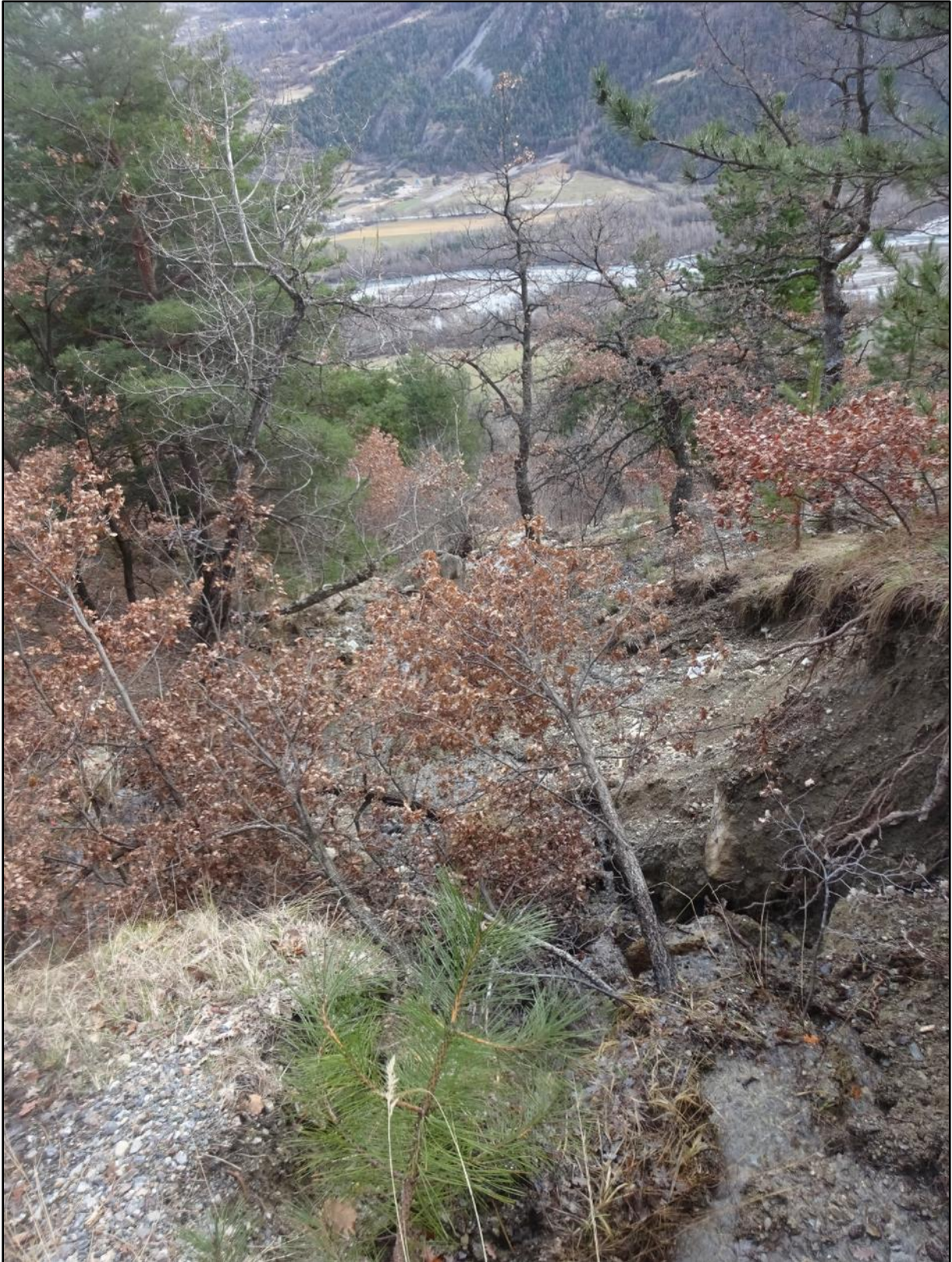
Image 14 : suite de l'éboulement
