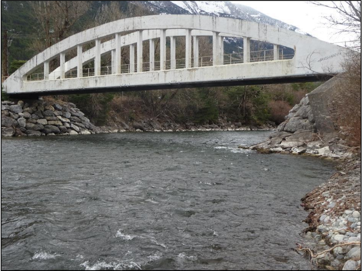
Image 6 : le pont et ses enrochements
