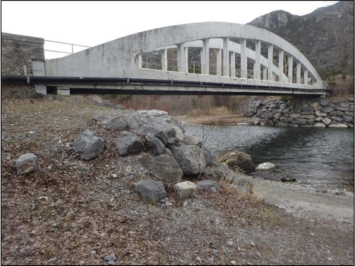
Image 7 : vue en aval de trois-quarts
