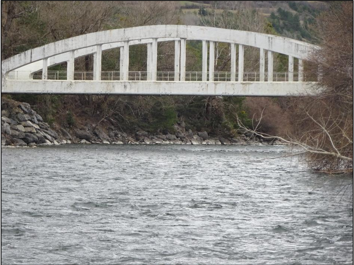
Image 4 : le pont de Saint-Crépin vu d'amont
