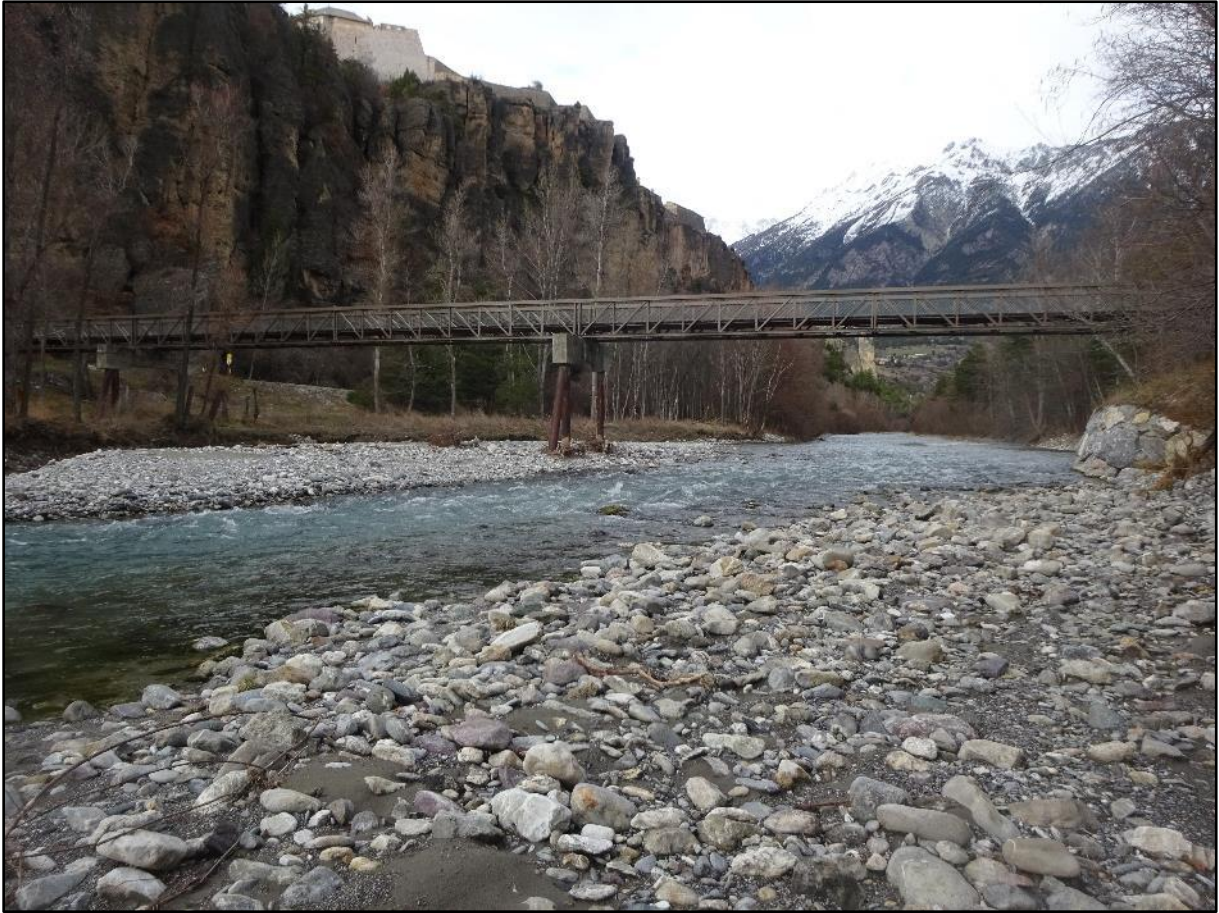
Image 11 : la passerelle de Gaboyer
