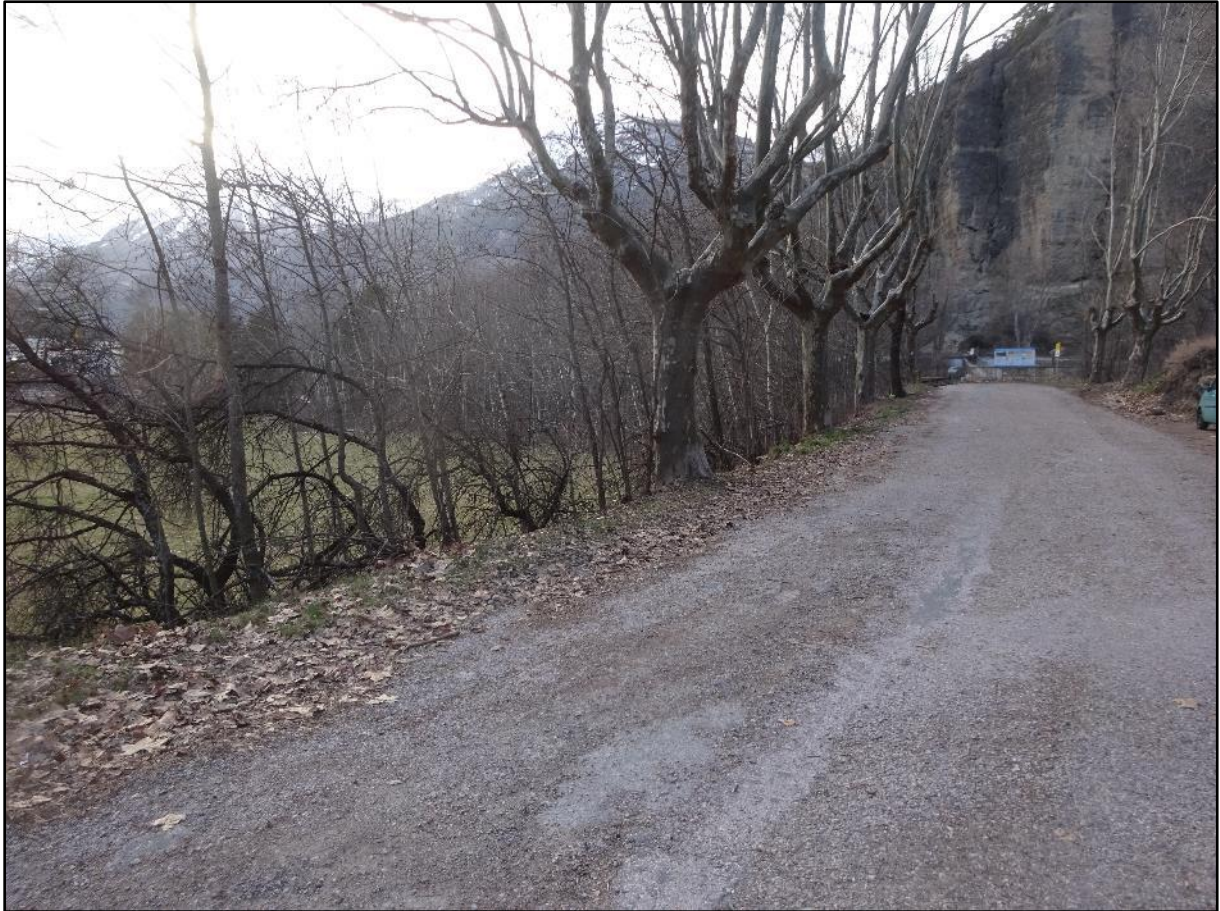
Image 25 : l'ancienne route de Guillestre à Saint-Guillaume
