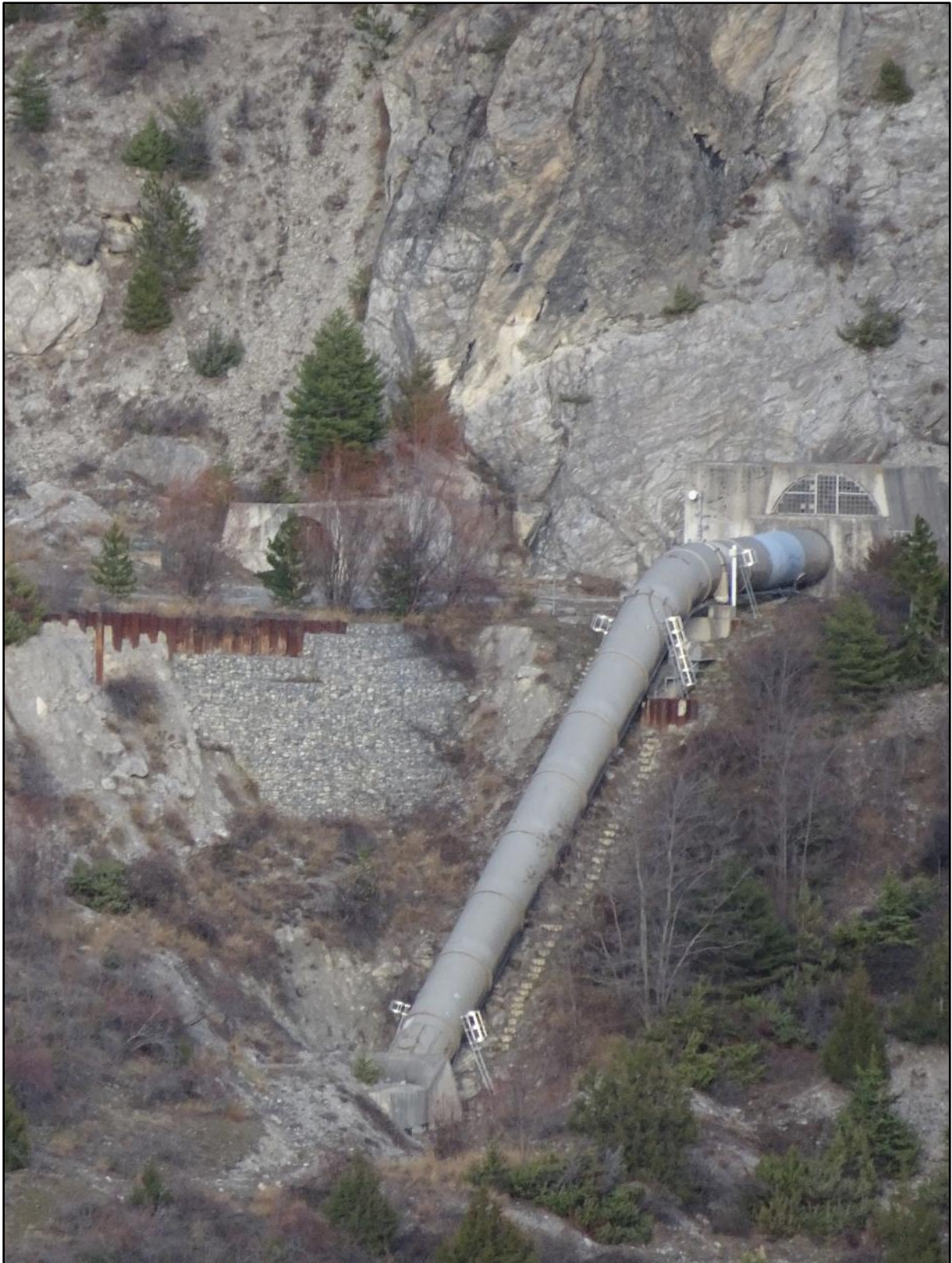
Image 20 : au zoom, l'arrivée de la conduite souterraine
