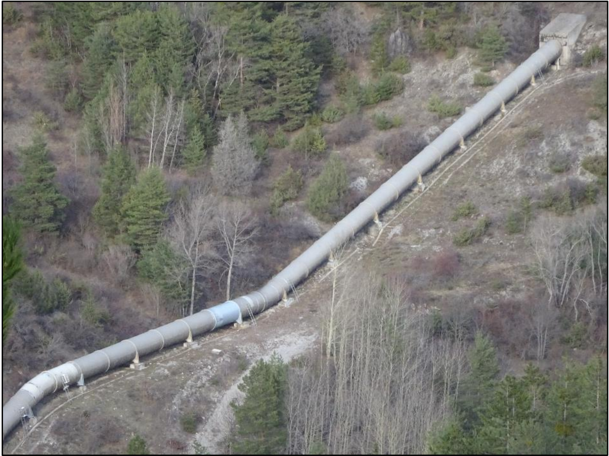
Image 21 : au zoom, la partie centrale de la conduite
