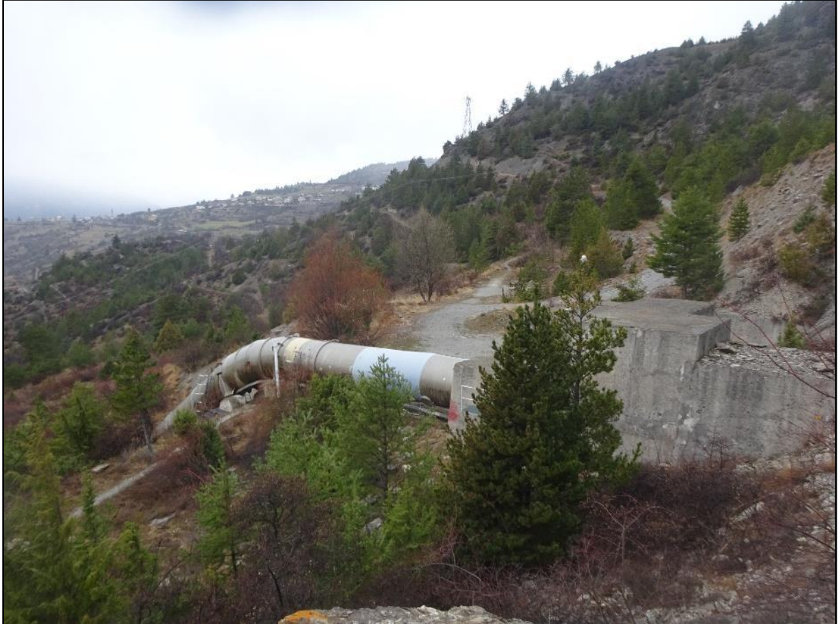
Image 4 : arrivée au débouché de la galerie souterraine
