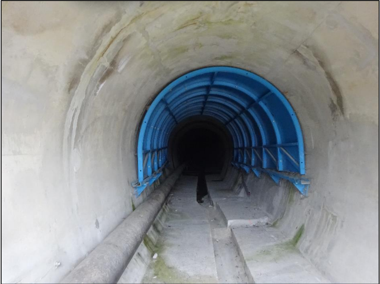
Image 9 : à l'entrée de la seconde galerie souterraine
