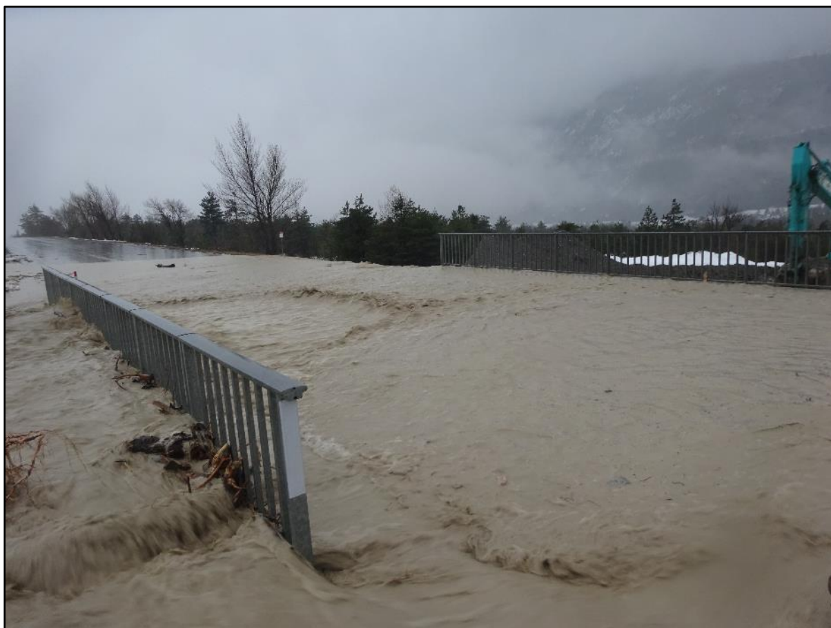
Image 4 : le pont du Merdanel
